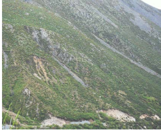
Queda de detritos
