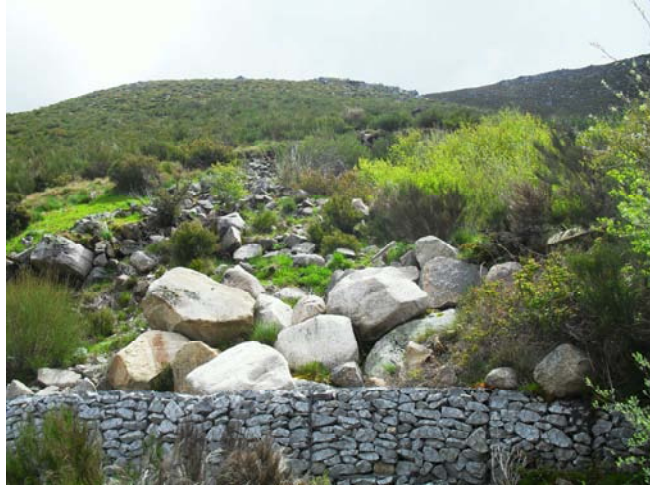
Queda de detritos travada pela construção de gaviões.
