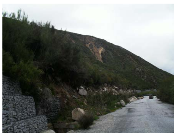
Queda de detritos
