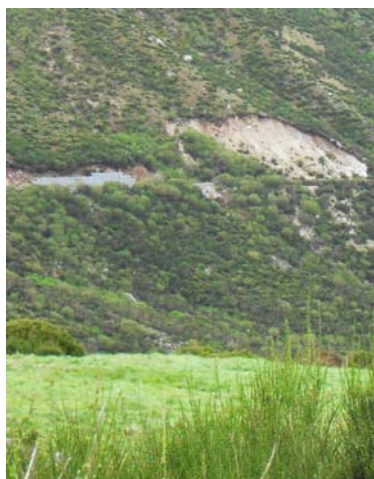
Queda de detritos
