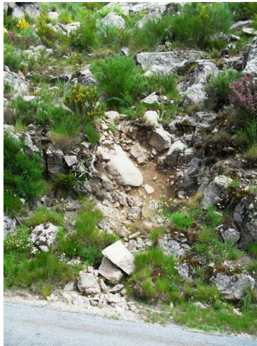
Queda de detritos recientes
