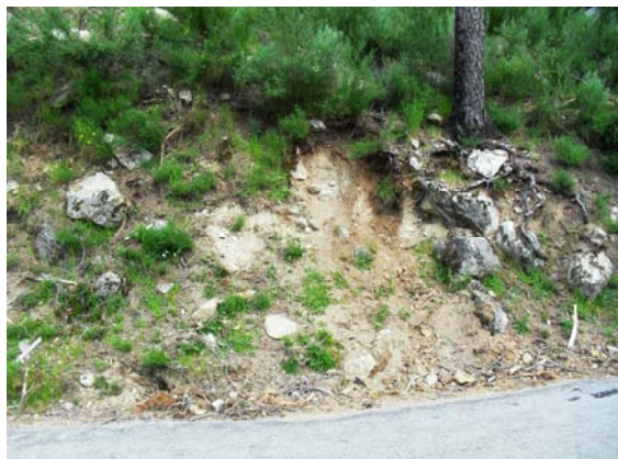
Queda de detritos em zona onde não se instalou vegetação.
