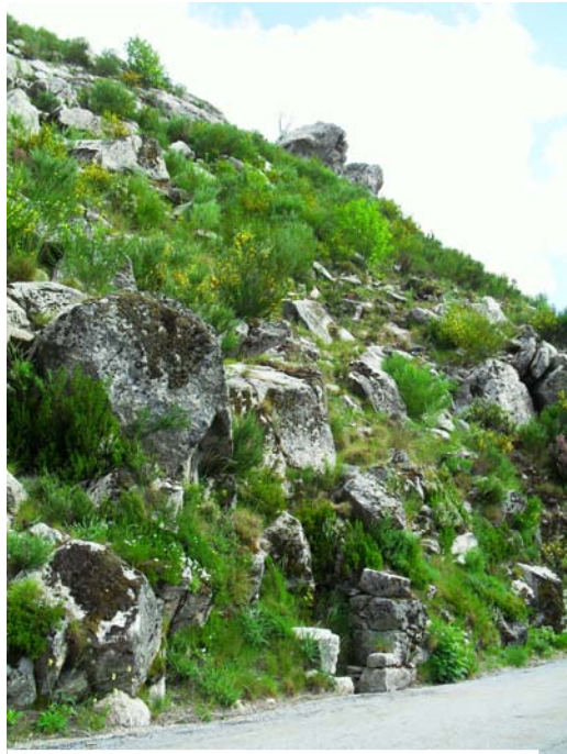
Queda de detritos históricos
