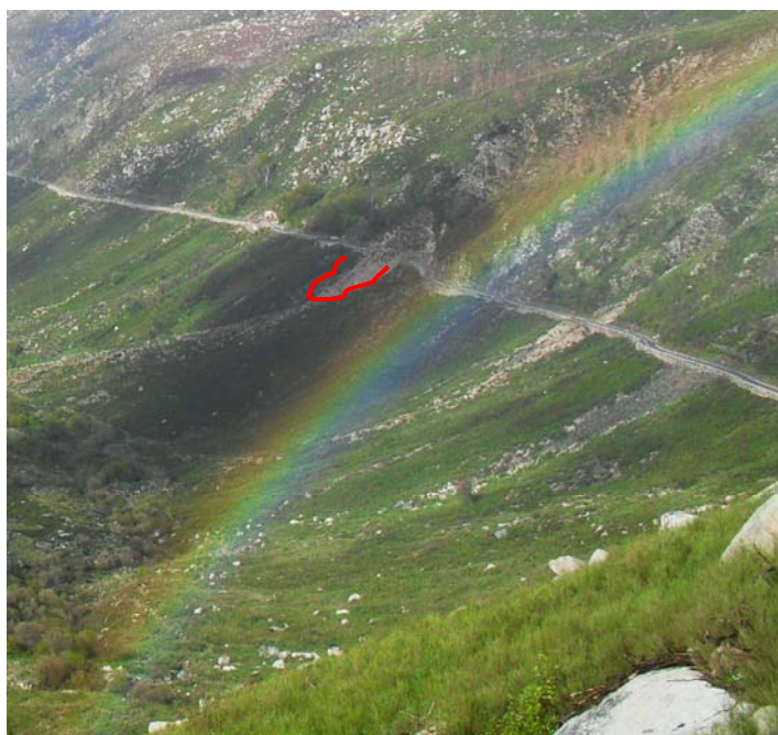
Fig. 30. Cicatriz de queda de detritos.
