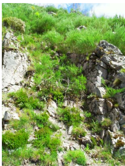
Rebentamento em caixa de falha
