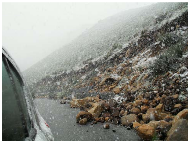
Queda de detritos
