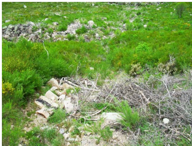
Queda de detritos
