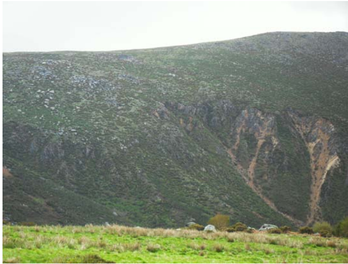
Queda de detritos
