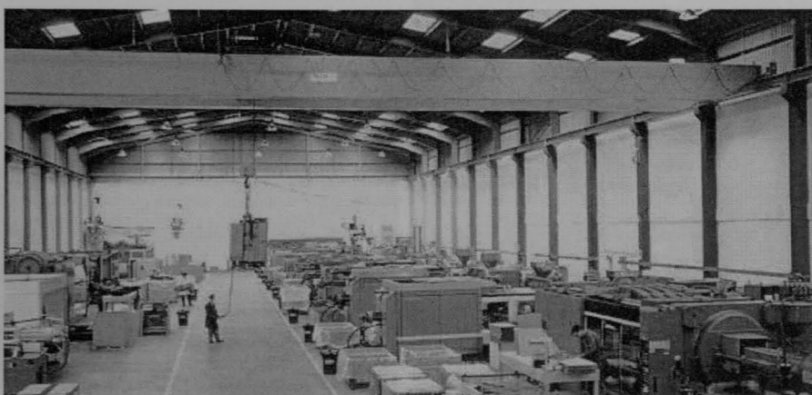
Fig. 4.3 – Pontes rolantes utilizadas para movimentação de moldes [1]
