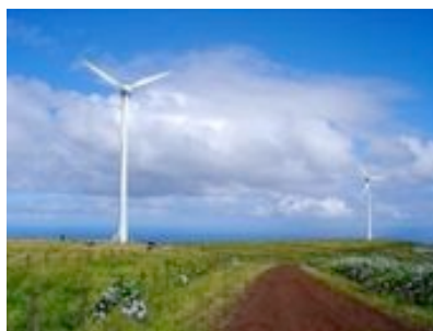
Figura 3.3 - Parque Eólico de Boca da Vereda.
