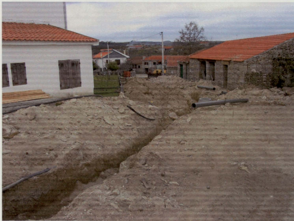
Foto 5 – Execução de infra-estruturas
