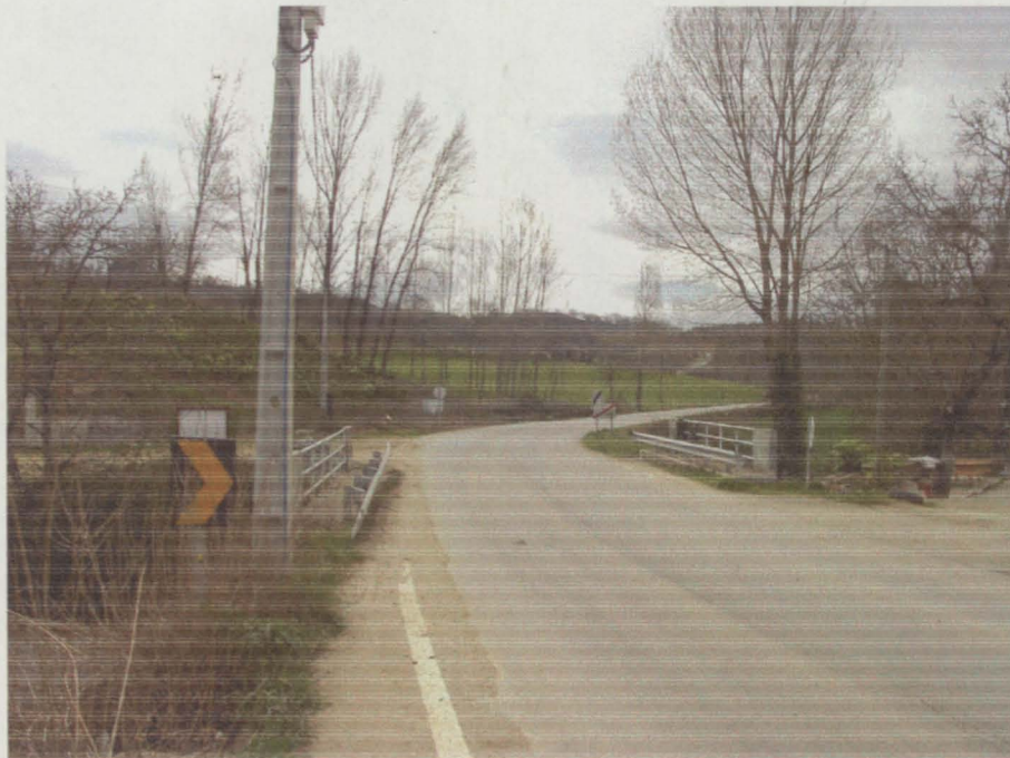
Foto 6 – Local da travessia suspensa do colector EG-01-TF-02 sobre a Ribeira de Ladrões
