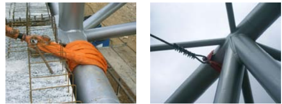
d) Pormenor da amarração dos cabos de aço às vigas principais.
