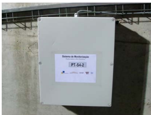
b) Caixa de ligação devidamente identificada.
