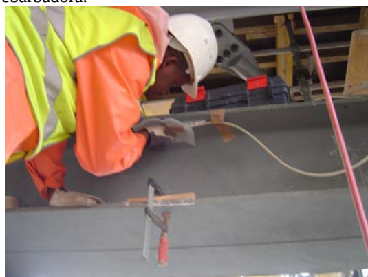
c) Instalação da protecção do sensor.
