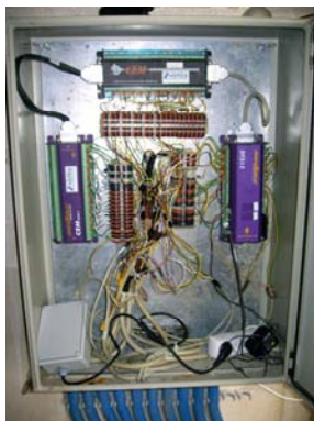
b) Sistema de aquisição contínuo de dados em obra.
