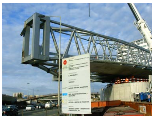
c) Lançamento da estrutura sobre os seus apoios definitivos.
