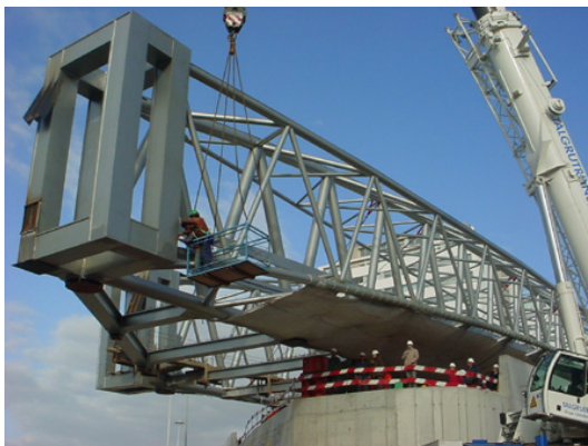
g) Lançamento da estrutura sobre a VCI.
