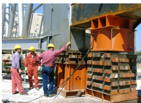
Fase 1 – Operação levantamento da estrutura.
