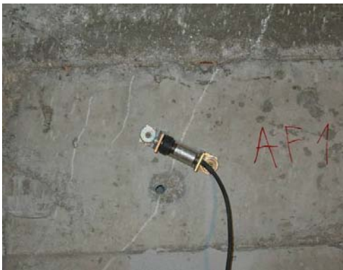
c) Medição da abertura de fendas - fissurómetro.
