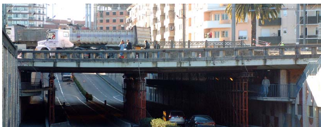
a) Vista frontal da passagem inferior à linha-férrea em Aveiro.
