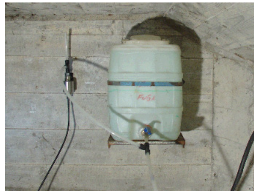
d) Medição de flechas – sistema de níveis líquidos.
