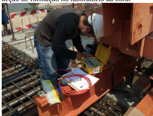
c) Demonstração do funcionamento do equipamento portátil de leitura para o controlo da instalação das cordas vibrantes.
