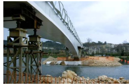
d) Retirada faseada dos cimbramentos.
