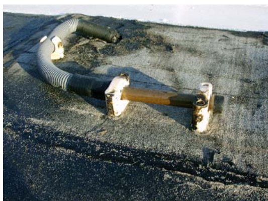
a) Sensor para a medição da temperatura ambiente (TS4_Amb).
