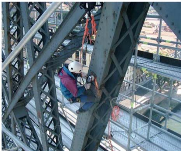
a) Preparação da superfície metálica.
