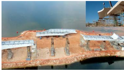
c) Construção com recurso ao cimbreiro ao solo.
