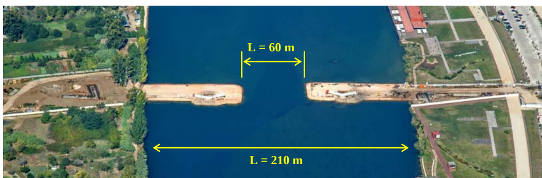
Figura 5.7 – Redução do canal do rio para uma largura de 60 m.
