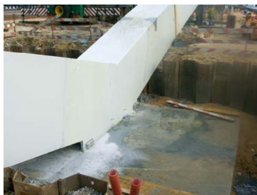
b) Arranque do arco nascente em construção.
