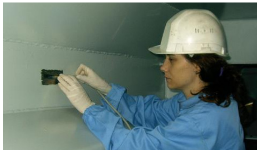
b) Colagem do sensor à superfície do aço.
