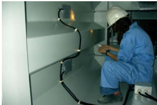
c) Protecção dos sensores e condução dos cabos até à caixa concentradora do sinal.
