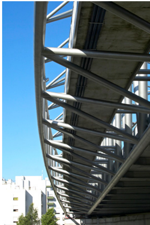
b) Vista inferior do tabuleiro: contraventamentos inferiores e carlingas.
