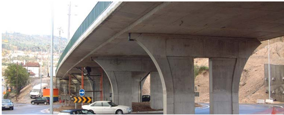
a) Viaduto ferroviário submetido a um ensaio de carga.
