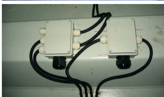
c) Caixas de ligação dos cabos provenientes de cada sensor instalados numa dada secção para posterior ligação num cabo de múltiplos condutores.
