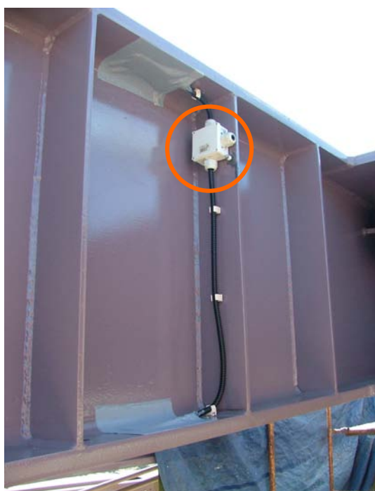
c) Caixas de ligação dos cabos provenientes de cada sensor instalados numa dada secção para posterior ligação num cabo de múltiplos condutores.
