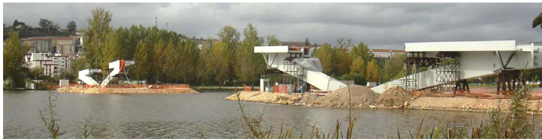
a) Evolução simultânea da construção dos arranques dos arcos durante a Fase 4.
