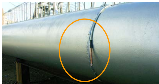
f) Sensor de temperatura encapsulado num tubo de cobre.
