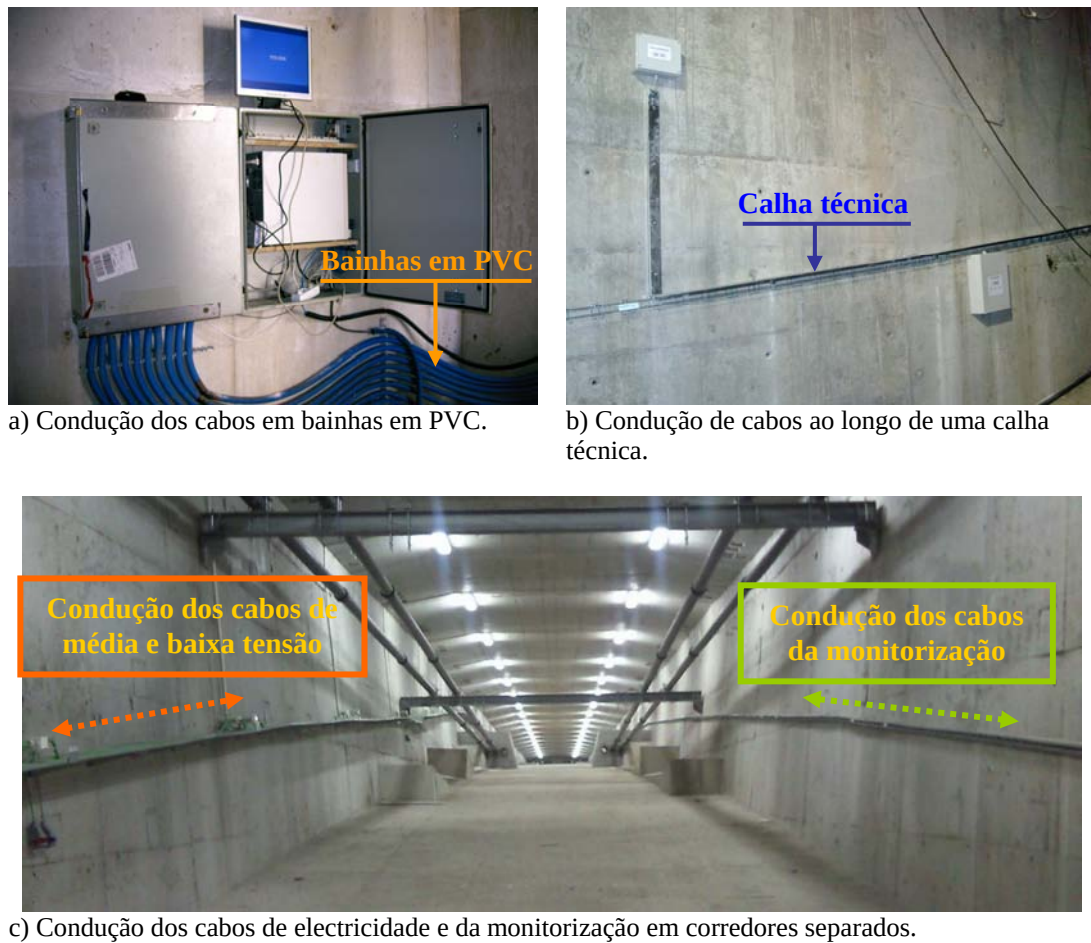
Figura 3.36 – Condução dos cabos em obra.
