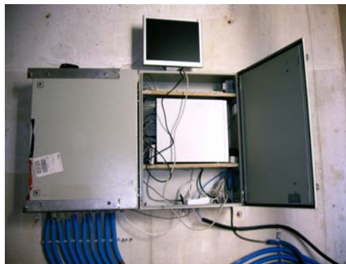
c) Computador que executa o pré-processamento dos registos em obra e comunica com o servidor.
