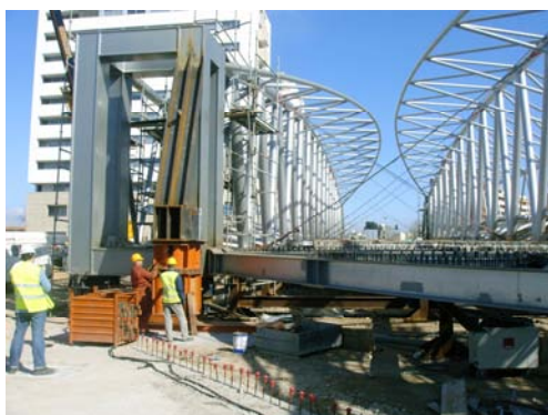
b) Operação de levantamento da estrutura.
