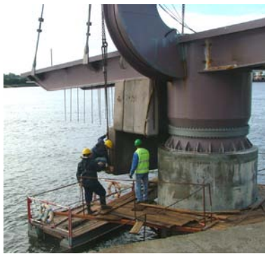
c) Colocação dos contrapesos em betão de massa conhecida.
