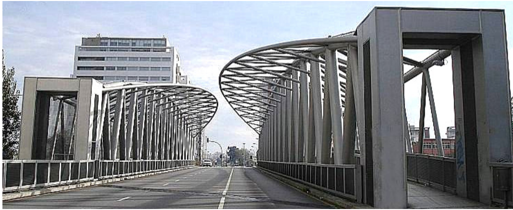
a) Vista frontal do viaduto das Andreas.
