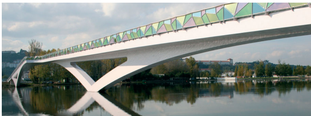
a) Vista lateral da ponte.
