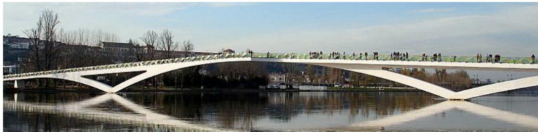
b) Vista geral da ponte.
