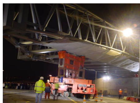
Fase 5 – Atravessamento da estrutura sobre a VCI.
