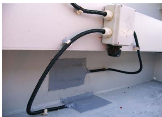
b) Caixa de ligação devidamente identificada.
