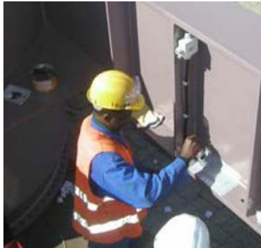
a) Instalação dos sensores tipo I em obra.
