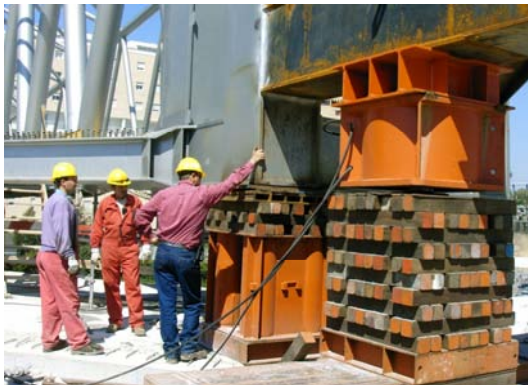
e) Operação de levantamento da estrutura.
