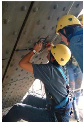
b) Soldagem dos cabos.
