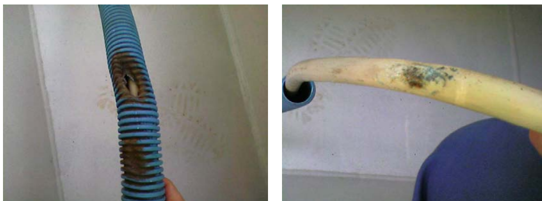
Figura 3.35 – Cabos danificados em obra devido a trabalhos de soldadura.
