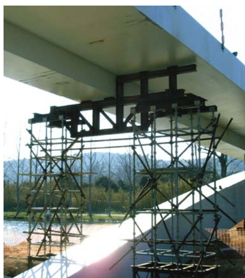
a) Execução em obra.
