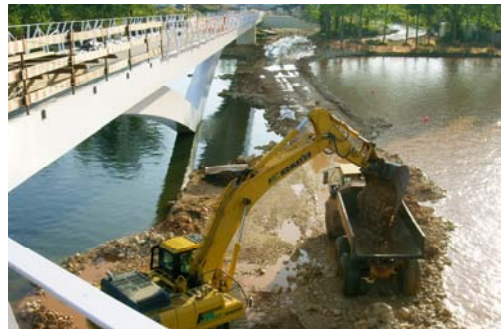
e) Remoção da plataforma de aterro após a Fase 24.
