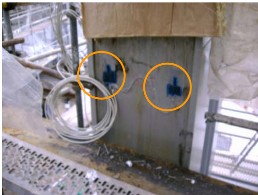
c) Extensómetros instalados nos PRS's: secção S25.
