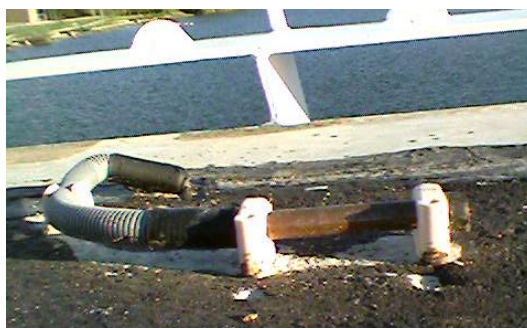
b) Sensor encapsulado – aplicação em obra.
