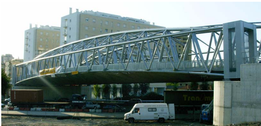
a) Vista geral do viaduto das Andresas.
