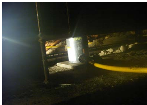
e) Actuador hidráulico instalado sob a estrutura.
