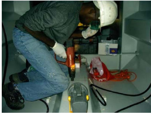
a) Fixação das caixas de concentração do sinal dos sensores.
