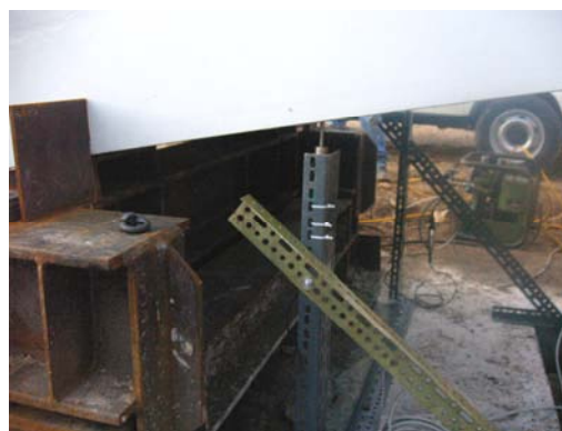
c) Medição dos deslocamentos verticais.
