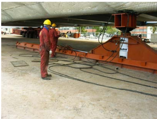
a) Skidshoes utilizados no transporte da estrutura.
