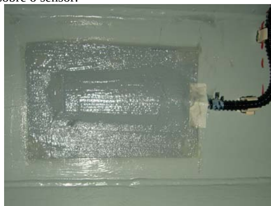
f) Aspecto final da instalação.
