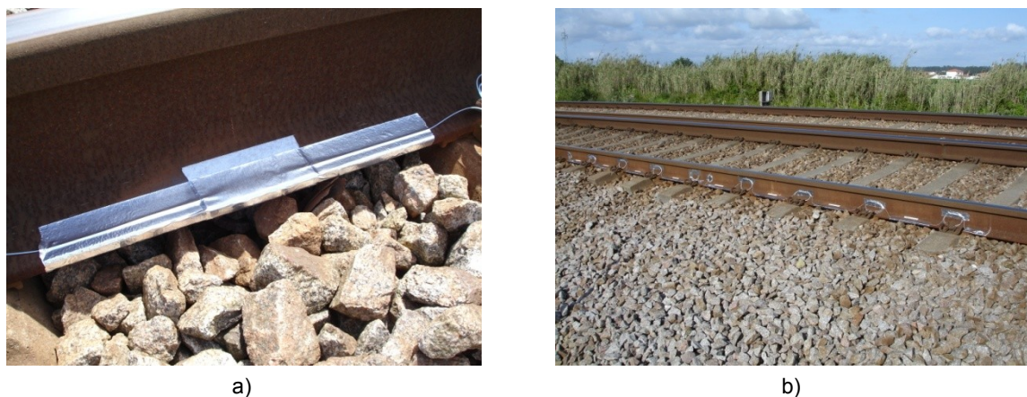
Fig. 34 Instalação pronta: a) Protecção; b) Vista geral.
