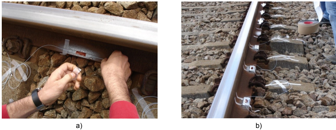
Fig. 33 Instalação dos sensores: a) alinhamento; b) posições de medição.
