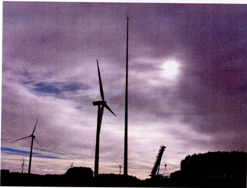
Figura 6- Torre Meteorológica no centro da imagem ( Met Mast ) de 75.75m, fabricada pela Metalgalva e instalada no Parque Eólico El Sombrio em Burgos, Espanha.
