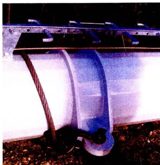
Figura 43 – Foto da peça de elevação do mastro de 75.75m durante a montagem em Burgos, Espanha
