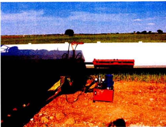
Figura 38 – Foto de uma montagem executada na horizontal com uma central hidráulica e dois macacos hidráulicos.
