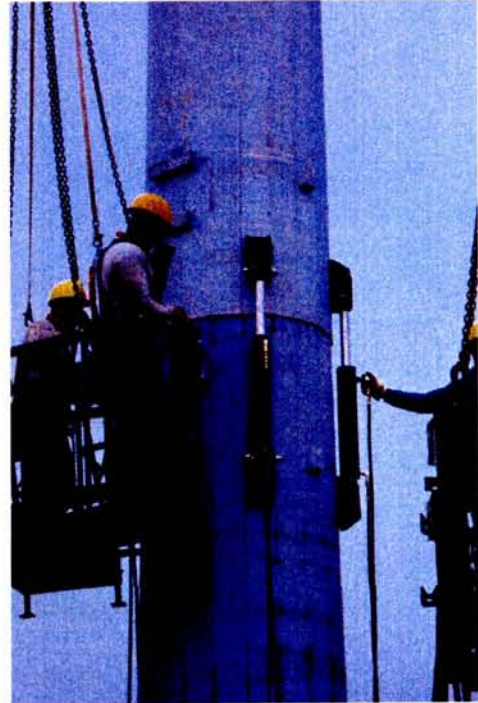
Figura 39 – Foto de uma montagem na vertical com aplicação das forças de encaixe em altura.
