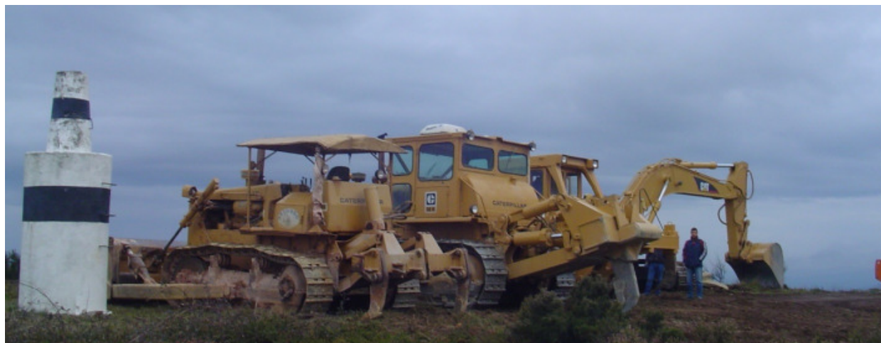
Figura 31 – Equipamento utilizado na abertura de acessos
