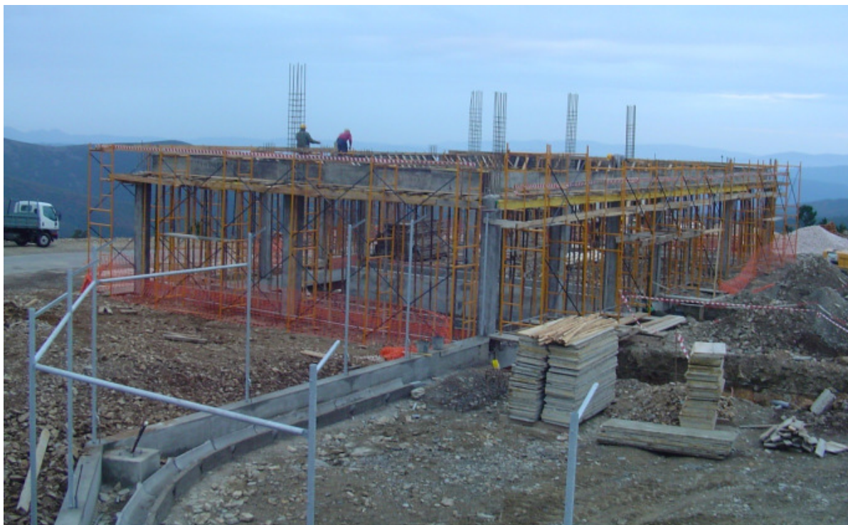
Figura 22 – Construção de um Edifício de Comando
