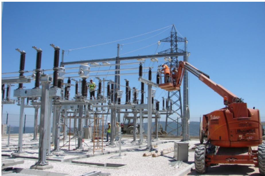
Figura 23 – Construção da Subestação
