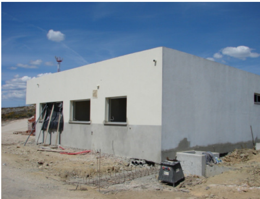
Figura 34 – Construção de um Edifício de Comando
