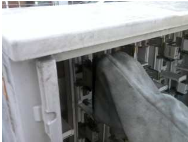
Figura 4.30: Colocação das Protecções.
