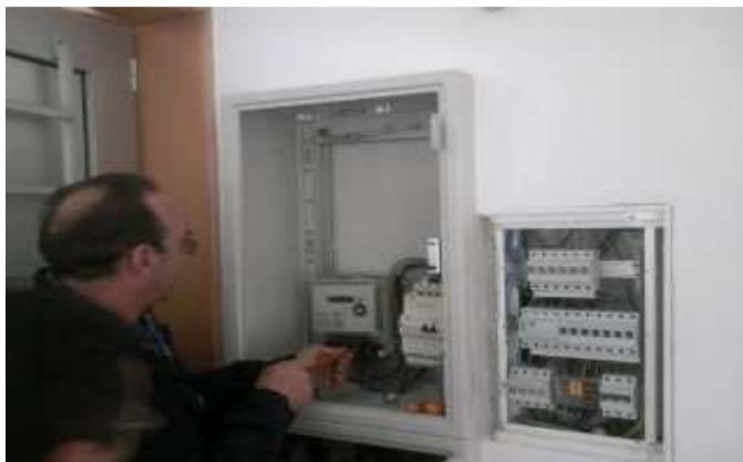
Figura 4.19: Retirar equipamento antigo.
