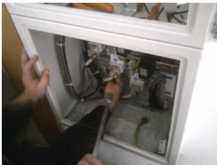
Figura 4.28: Colocação do sistema de protecção no quadro de entrada.
