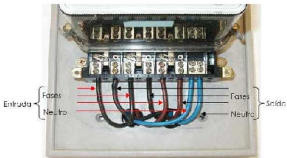
Figura 3.11: Montagem real de um Esquema de ligações Trifásico [13].
