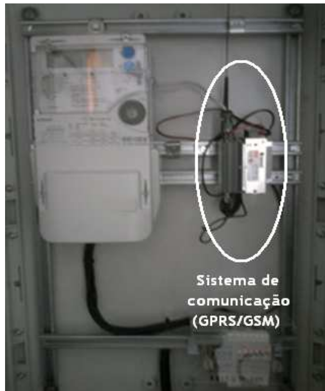
Figura 4.26: Colocação do Modem para se efectuar comunicação de dados.
