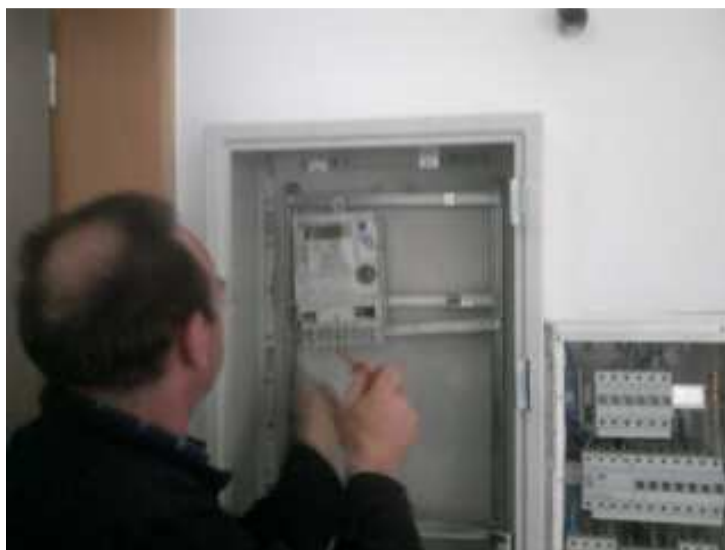
Figura 4.20: Colocação do novo equipamento.
