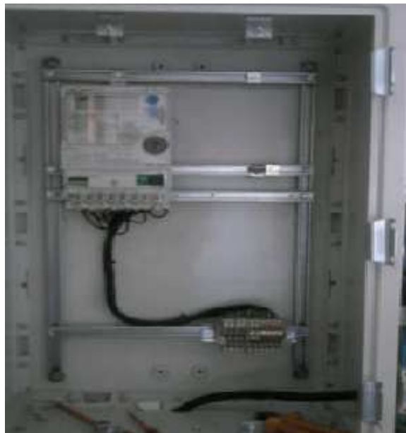
Figura 4.24: Ligação do Contador à Régua de Bornes.
