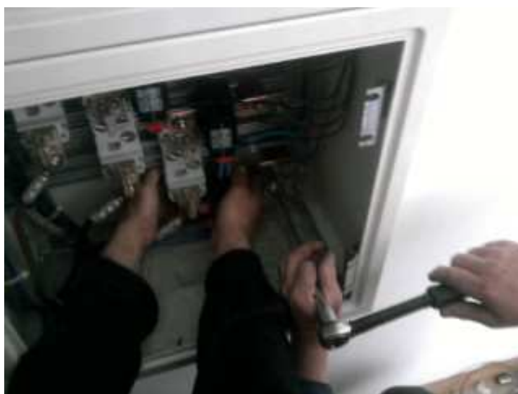
Figura 4.29: Aperto final aos barramentos para que não haja problemas futuros.
