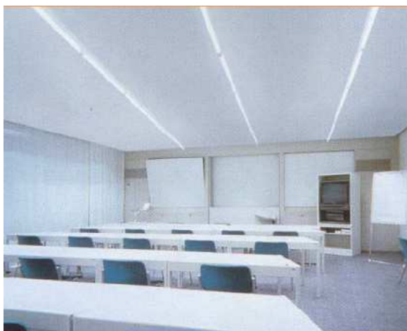
Figura 13: Exemplo de orientação de luminárias (Adaptado de Gaspar)
