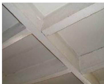
Fig. 2.5 – Tarugamento simples em vigamento. Edifício do Largo de São Domingos, Porto (Ilharco et al.; 2006).
