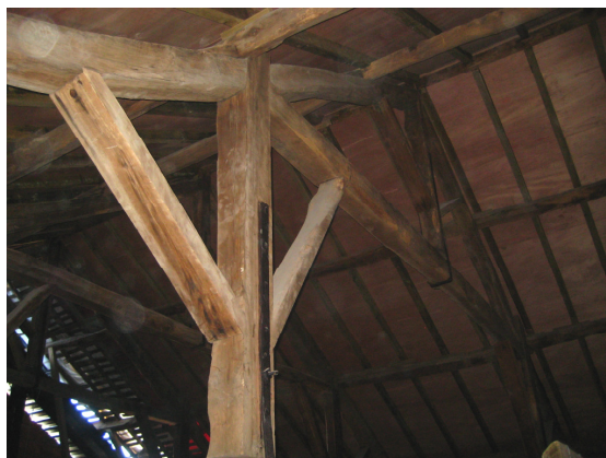
Fig. 6.10 – Estrutura principal em madeira da cobertura.
