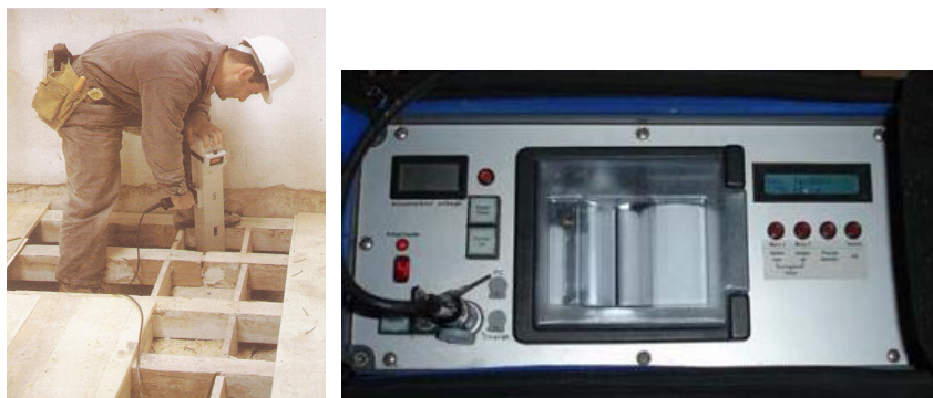
Fig. 3.1 – Utilização de Resistógrafo em estrutura (à esquerda, Tampone;2002) e bateria e impressora portátil (à direita, Júnior;2006).
