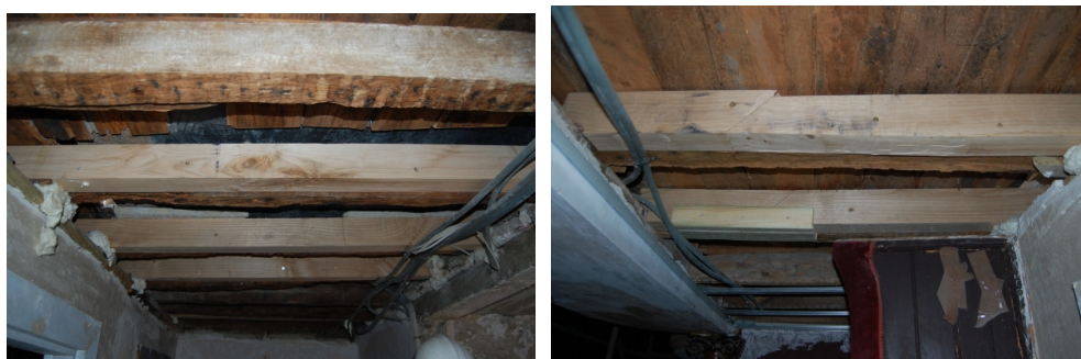
Fig. 6.25 – Reforço de vigas com a colocação de novos elementos do piso 1.
