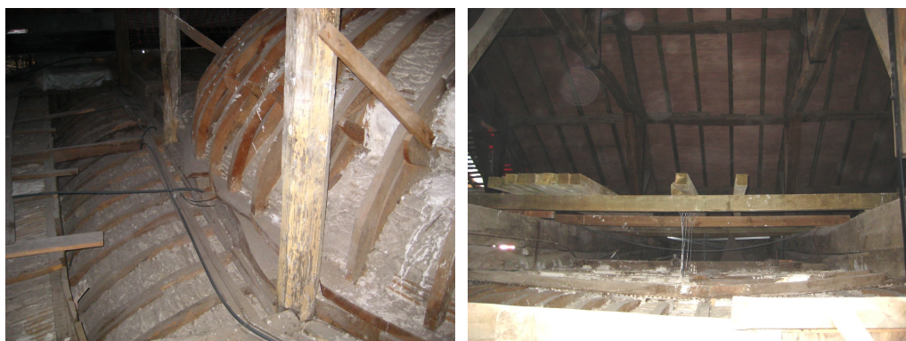
Fig. 6.11 – Reverso da abóbada e seu escoramento aos pilares (à esquerda) e sistema de suporte a elementos de madeira (à direita).
