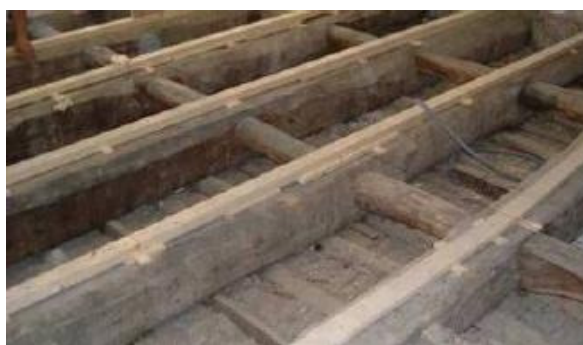
Fig. 5.46 – Calços aplicados em pavimento antigo de madeira (Ilharco et all;2007).
