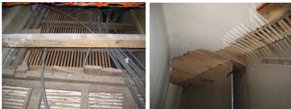
Fig. 6.22 – Colocação de novos fasquiados de suporte de estuques.
