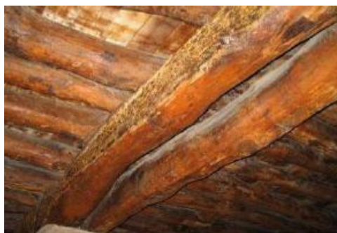
Fig. 2.2 – Colocação de vigas transversais para diminuição de vão, Casa do Infante, Porto (Dias;2008).
