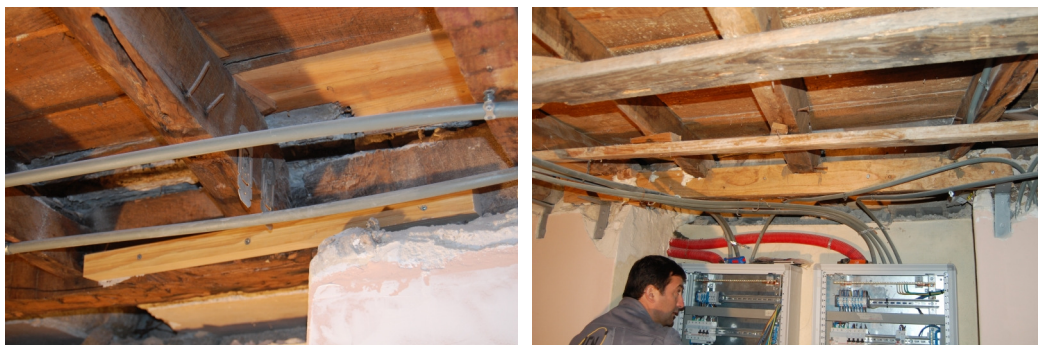
Fig. 6.28 – Introdução de frechal de madeira para apoio de vigas dos pavimentos.
