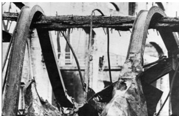
Fig. 4.14 – Exemplo da resistência de elemento de madeira comparado com o de aço.
