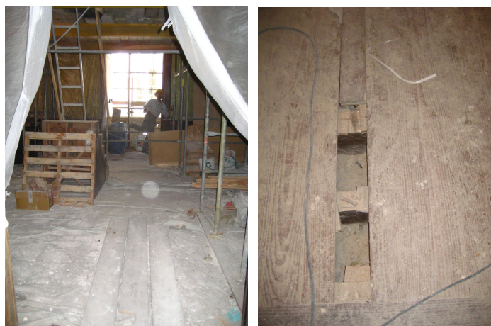
Fig. 6.20 – Pavimento do Salão Nobre.
