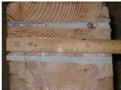
Fig. 5.9 – Viga reforçada com compósitos de FRP.
