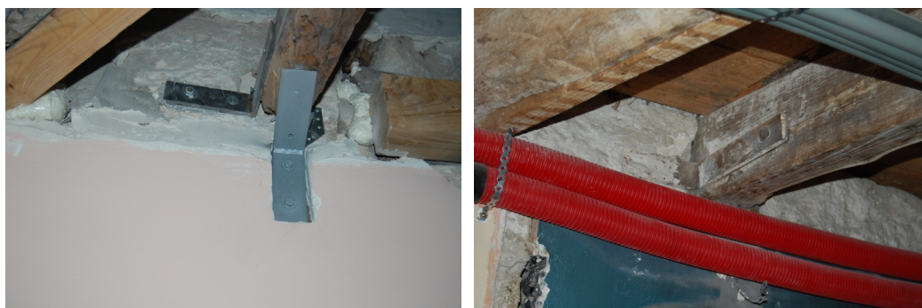
Fig. 6.26 – Reforço dos apoios das vigas dos pavimentos com elementos metálicos.
