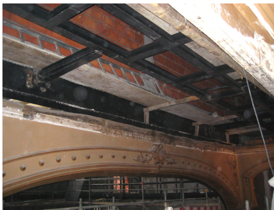
Fig. 6.12 – Estrutura que serve de passadiço para circulação na zona de cobertura.
