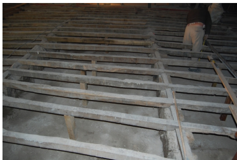
Fig. 6.24 – Reforço do pavimento do piso 0 com recurso a escoras de madeira.
