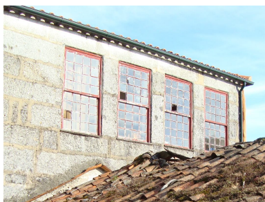
Fig.5.29. – Impossibilidade de aplicação de portadas exteriores opacas na habitação 3
