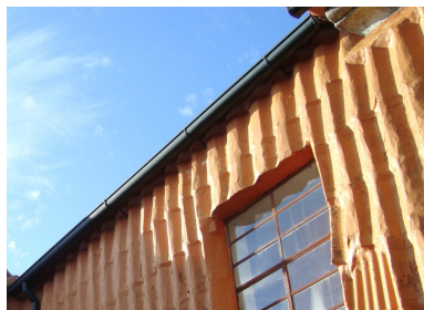
Fig.4.22. – Parede exterior Pext 3 da habitação 3
