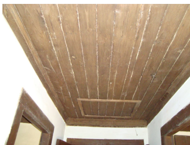
Fig.4.37. – Cobertura interior Cob 1 da habitação 3
