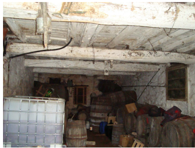
Fig.4.40. – Pavimento interior Pav 2 da habitação 3
