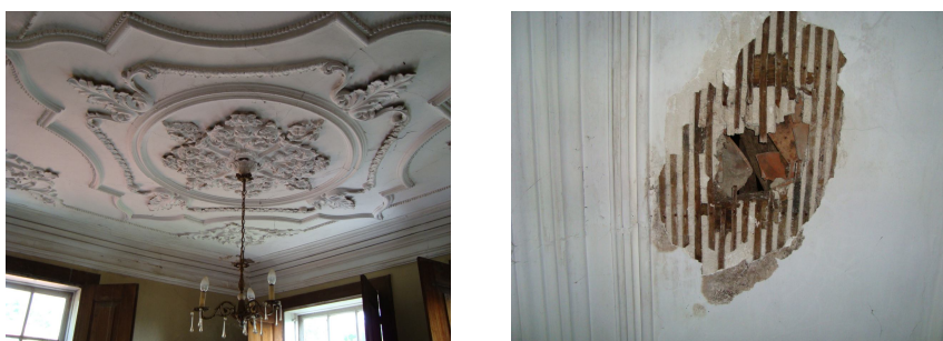
Fig.4.38. – Cobertura interior Cob 2 da habitação 3
