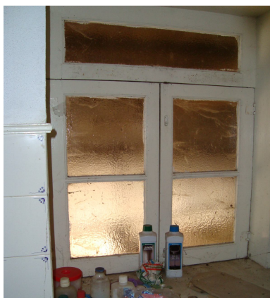
Fig.4.30. – Vãos envidraçados Env 4 (vidro colorido) da habitação 3
