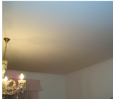
Fig.4.34. – Cobertura interior Cob1 da habitação 1
