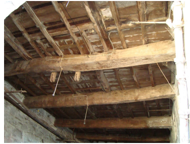
Fig.4.23. – Pavimento exterior Pav 1 da habitação 3
