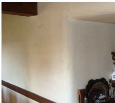
Fig.4.36. – Parede interior Pint 1 da habitação 3
