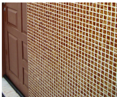
Fig.4.12. – Parede exterior Pext 1 da habitação 2
