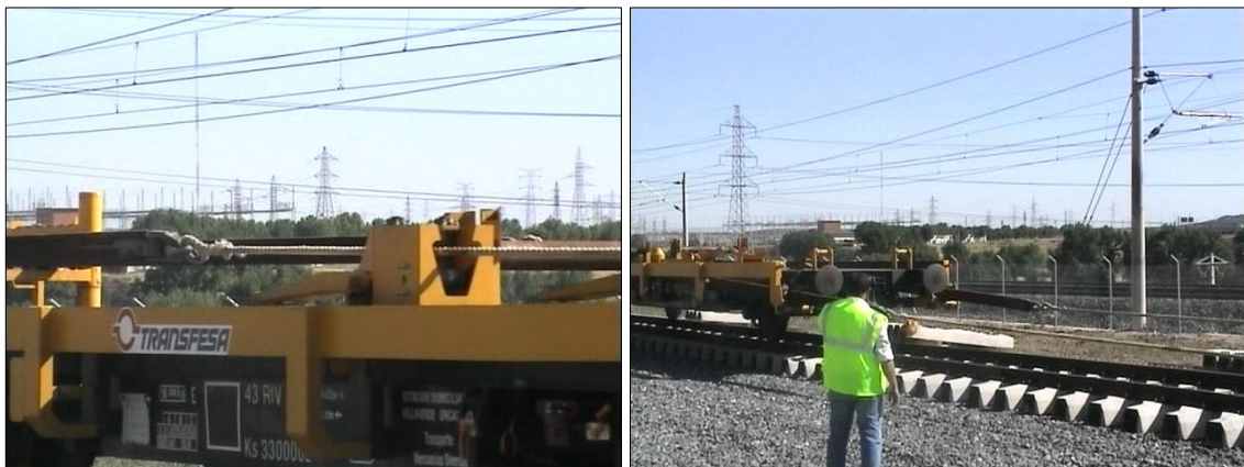
Fig. 3.17.1 e 3.17.2 – Descarga dos carris [7]
