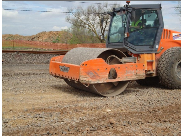
Fig. 3.6 – Compactador vibrador misto
