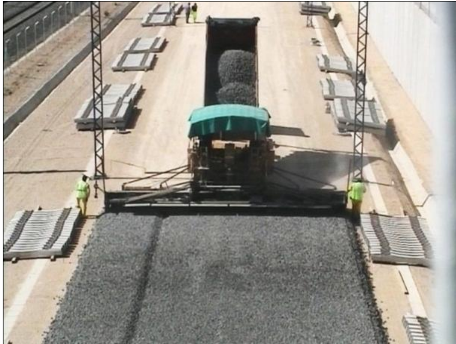
Fig. 3.10 – Espalhamento do balastro [7]
