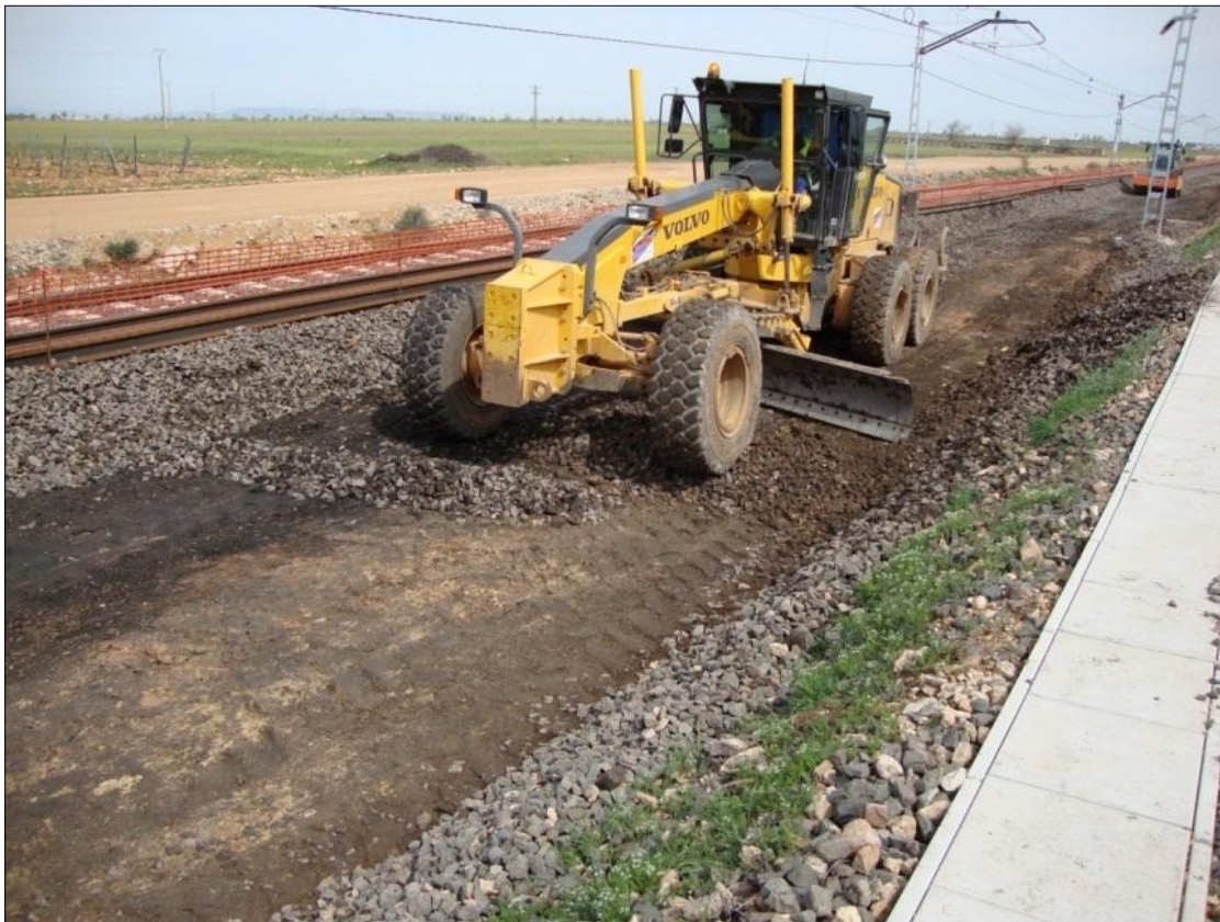
Fig. 3.5 – Nivelamento da plataforma com motoniveladora
