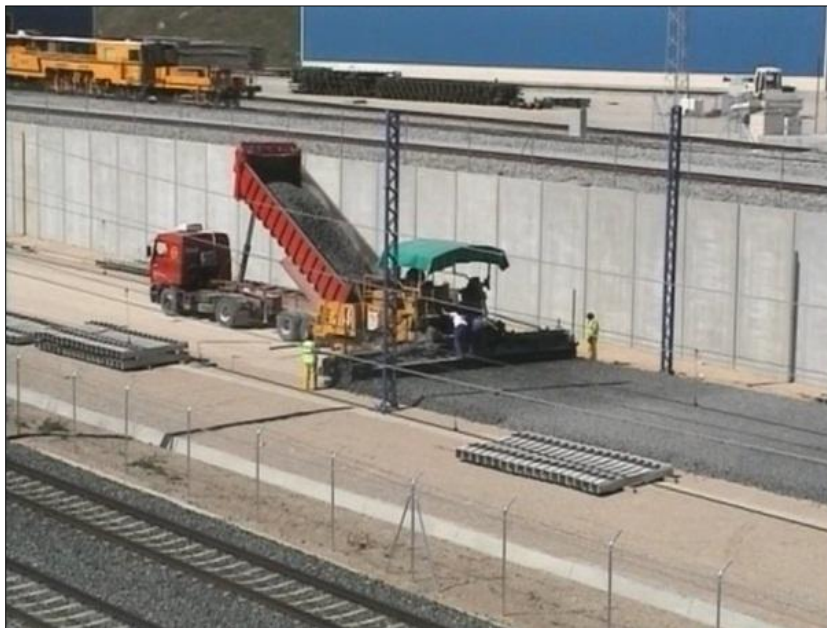
Fig. 3.9 – Camião basculante e mesa espalhadora de balastro [7]
