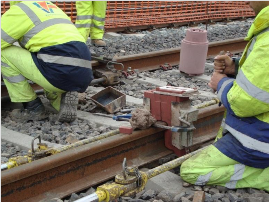
Fig. 3.29 – Preparação do molde para soldadura
