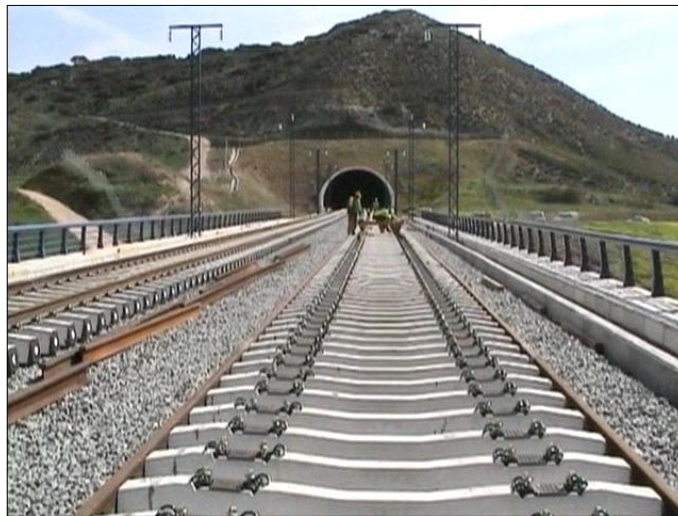
Fig.3. 20 – Via preparada para colocação dos carris [7]
