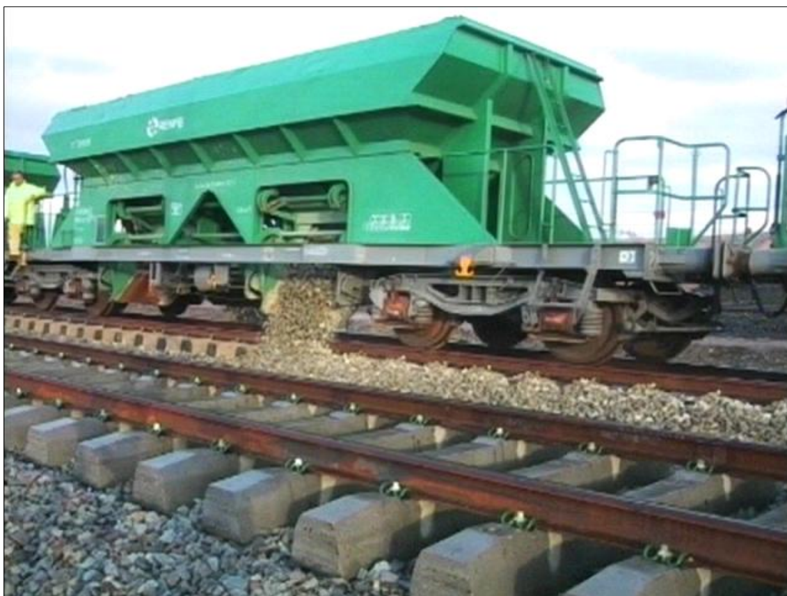
Fig. 3.26 – Descarga de balastro com um balastreiro [7]
