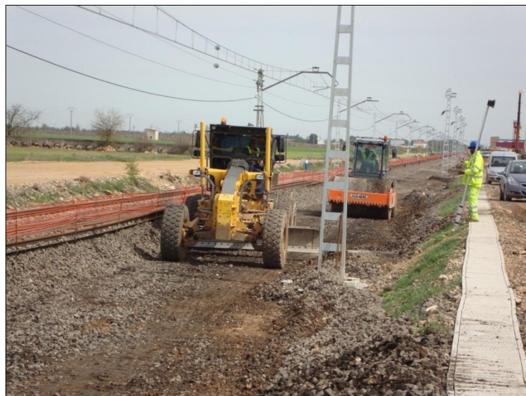
Fig. 3.7 – Funcionamento conjunto da motoniveladora e do compactador
