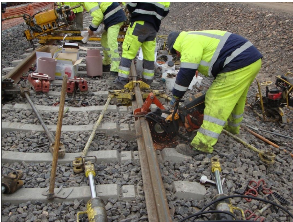
Fig. 3.28 – Corte dos carris
