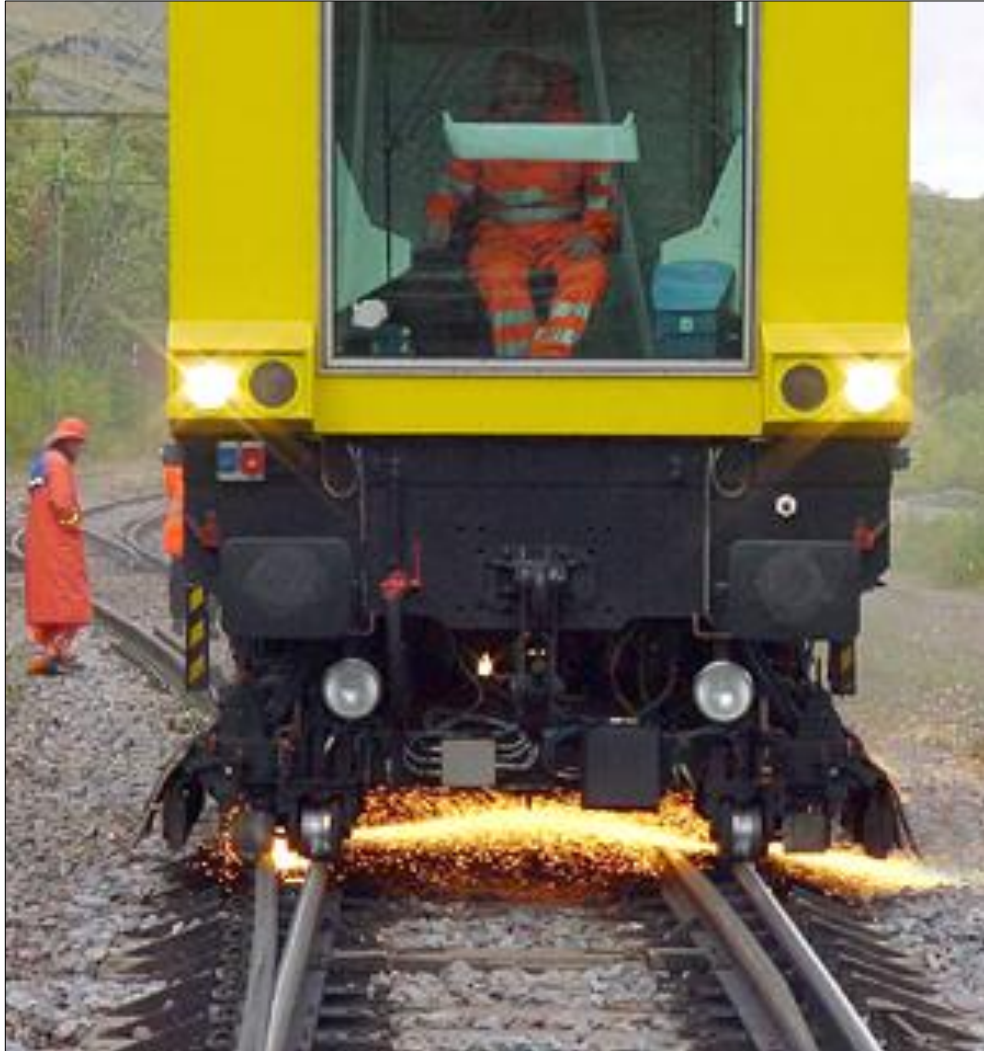
Fig. 3.37 – Esmerilagem final da via
