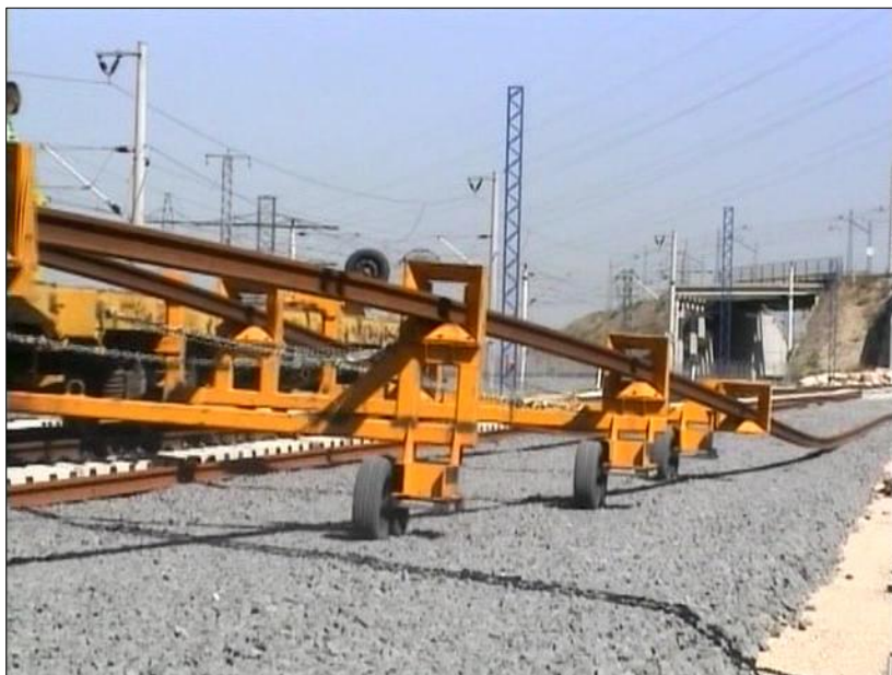
Fig. 3.19 – Descarga dos carris na via paralela [7]
