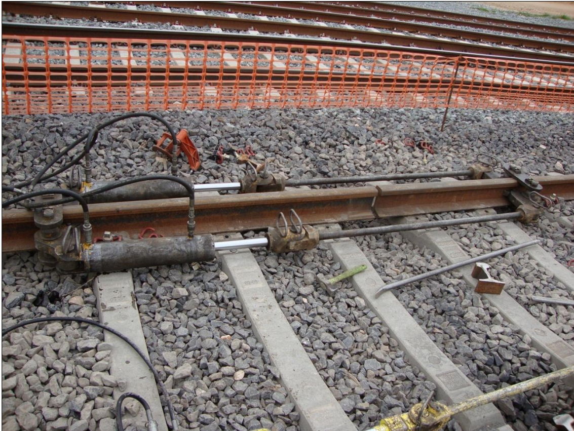
Fig. 3.36 – Tensor utilizado para regularização de tensões nas BLS.
