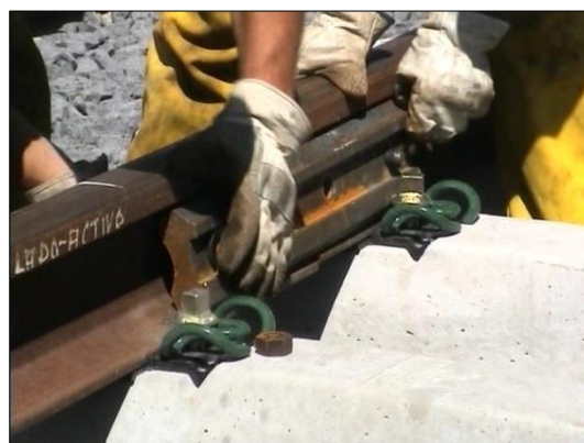
Fig. 3.15 – Colocação das juntas na via provisória
