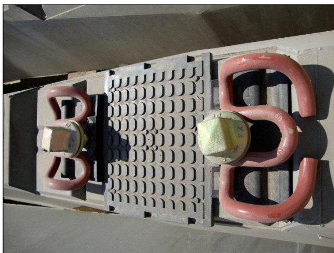
Fig. 4.47 - Fixação utilizada na obra de renovação.
