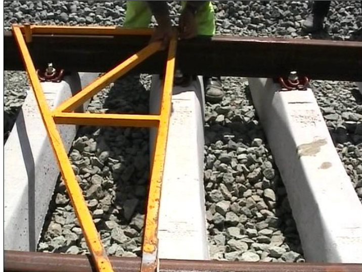
Fig. 3.24 – Travessa ainda por ajustar [7]
