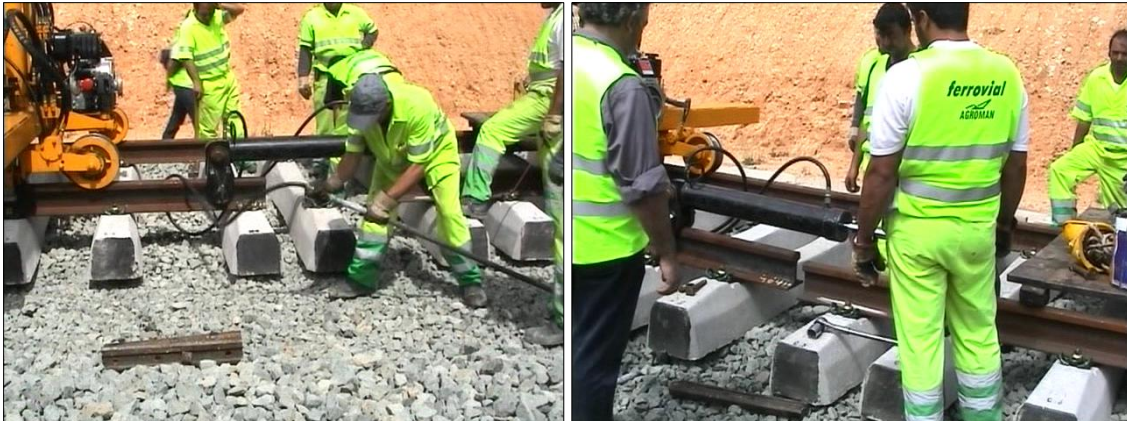
Fig. 3.22 – Folga das juntas das barras longas soldadas [7]
