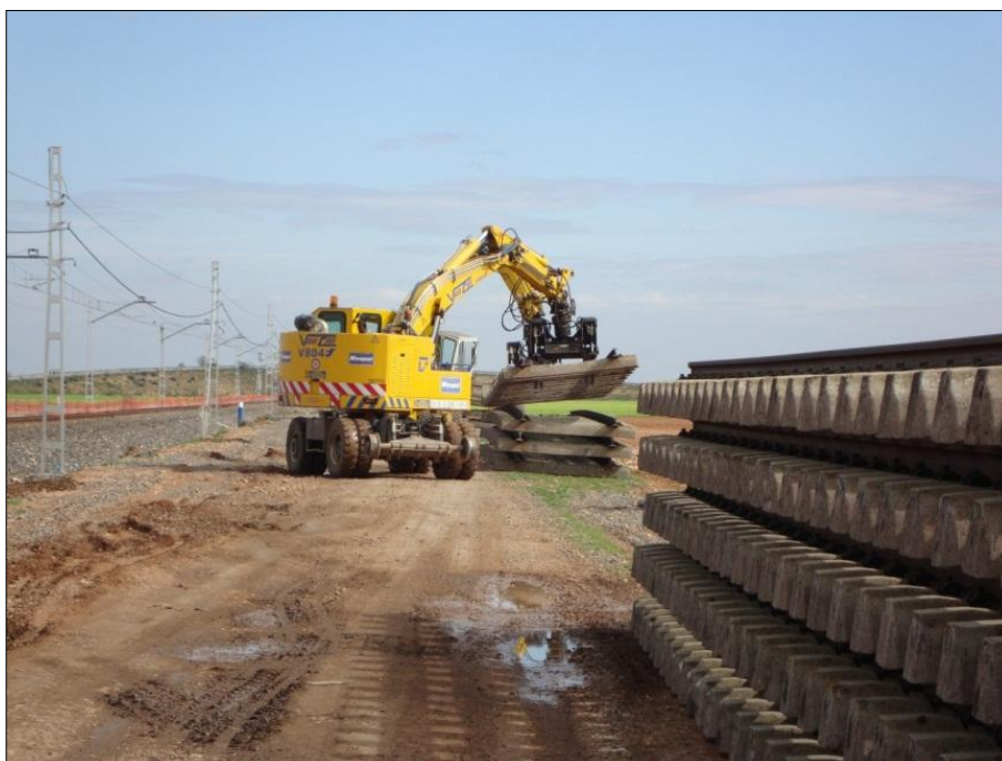
Fig. 3.2 – Levantamento de travessas com uma vaiacar
