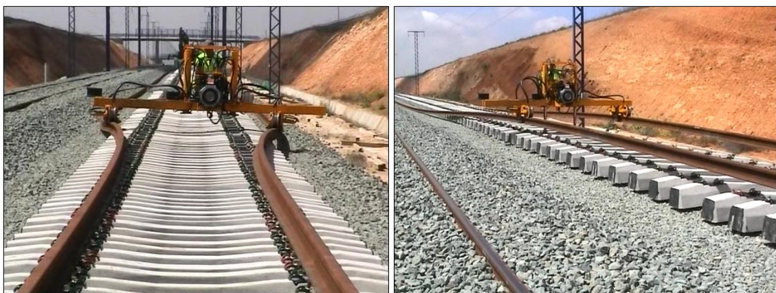
Fig. 3.21.1 e 3.21.2 – Montagem dos carris por meio de posicionadores de carris [7]
