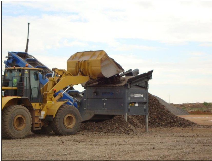
Fig. 4.43 – Alimentação de balastro por pá carregadora de rodas
