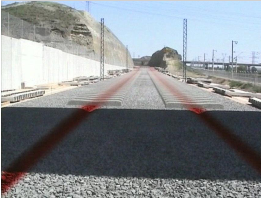
Fig. 3.8 – Travessas sob a primeira camada de balastro [7]
