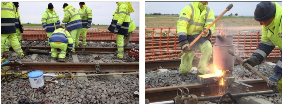
Fig. 4.49.1 e 4.49.2 – Soldaduras aluminotérmicas
