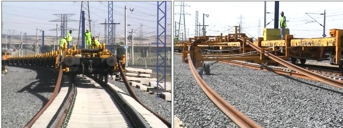
Fig. 3.16.1 e 3.16.2 – Descarga de carris: via condutora (à esquerda) e paralela (à direita) [7]
