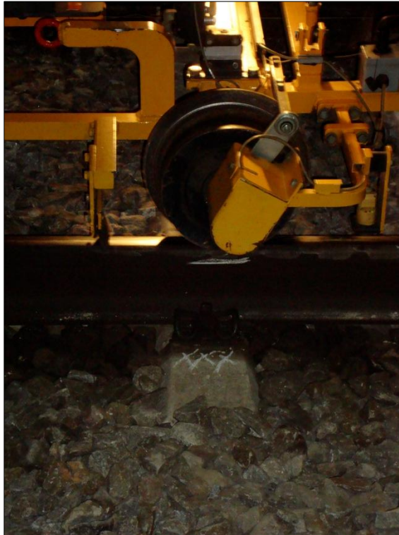
Fig. 5.56 – Ponto de referência para início dos trabalhos de ataque
