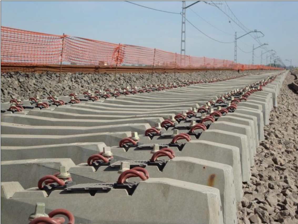
Fig.4.45.2 – Travessas mono-bloco pré-esforçadas: tipo PR-01
