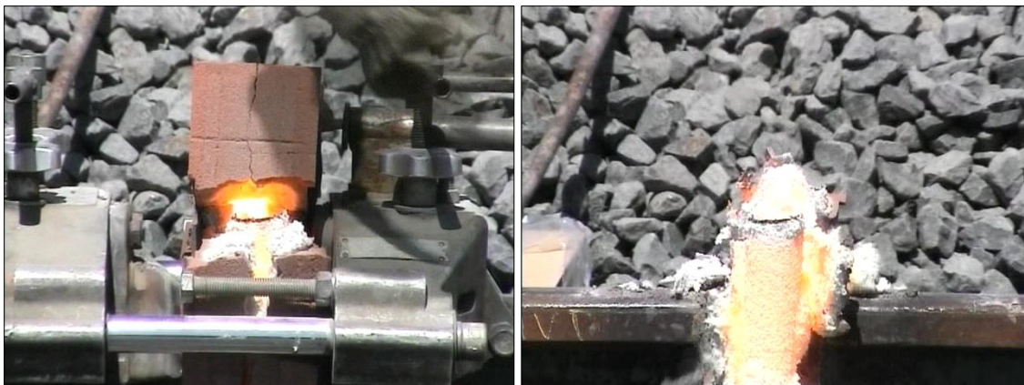
Fig. 3.31.1 e 3.31.2 – Corte do molde por meio de uma prensa hidráulica [7]
