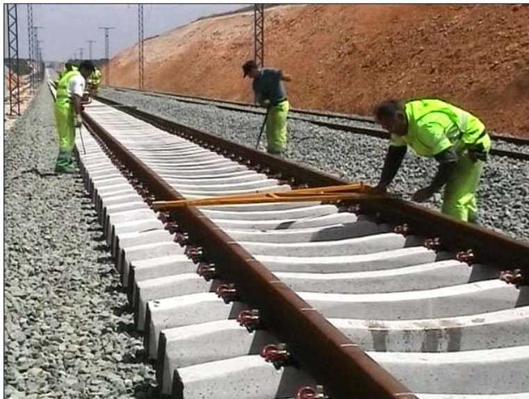
Fig. 3.23 – Verificação dos parâmetros de via [7]
