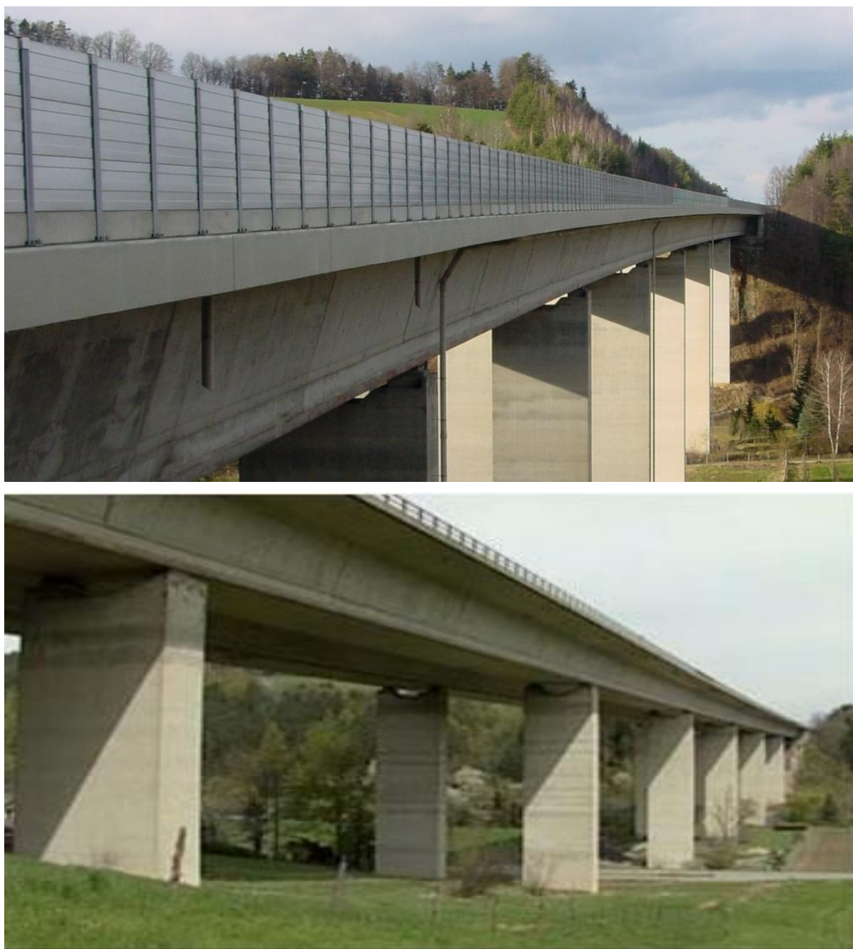
Figura 4.1 – Vistas gerais da ponte de Talübergang Warth
