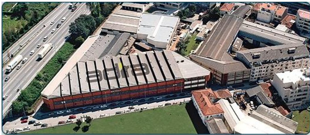
Fig 2.2 - Vista da empresa ADIRA S.A.
