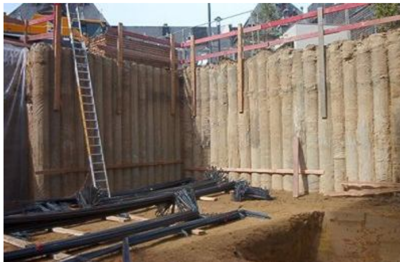
Fig. 6: Cortina de Estacas contíguas ( http://www.franki-geotechnics.be )
