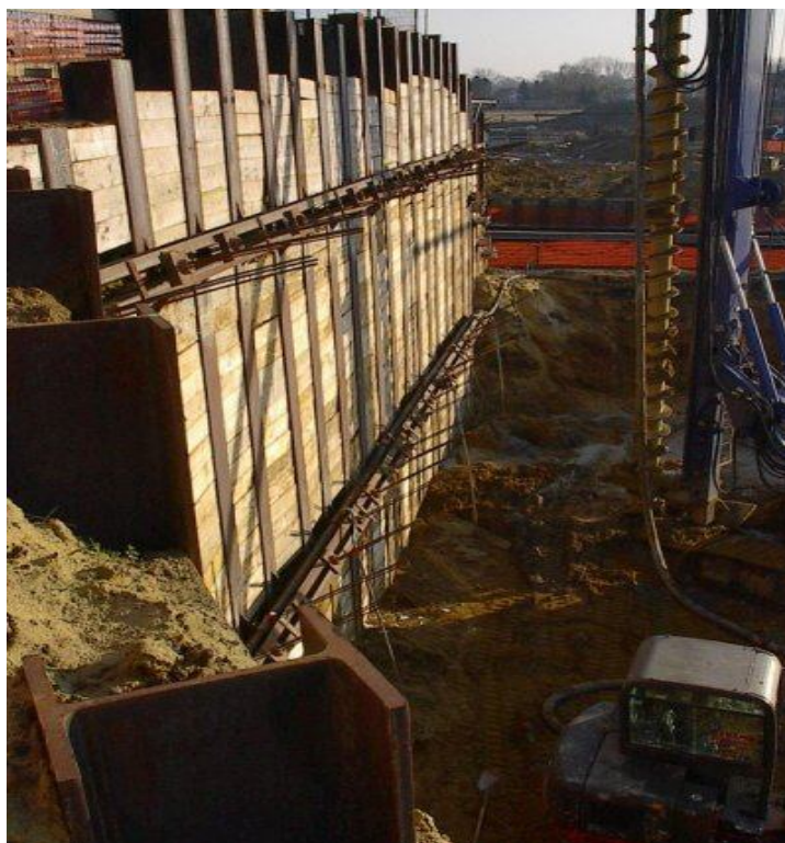
Fig. 1: Cortina Tipo Berlim multiancorada ( http://www.franki-geotechnics.be )
