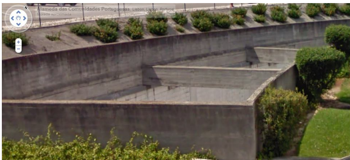
Fig. 13: Obra em linha escorada com seis metros de vão
