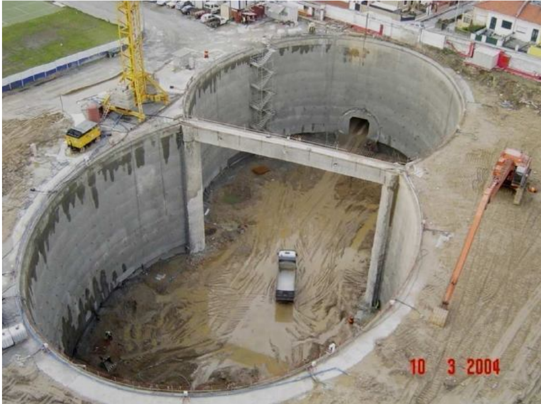
Fig. 15: Vista aérea da escavação da estação de Salgueiros
