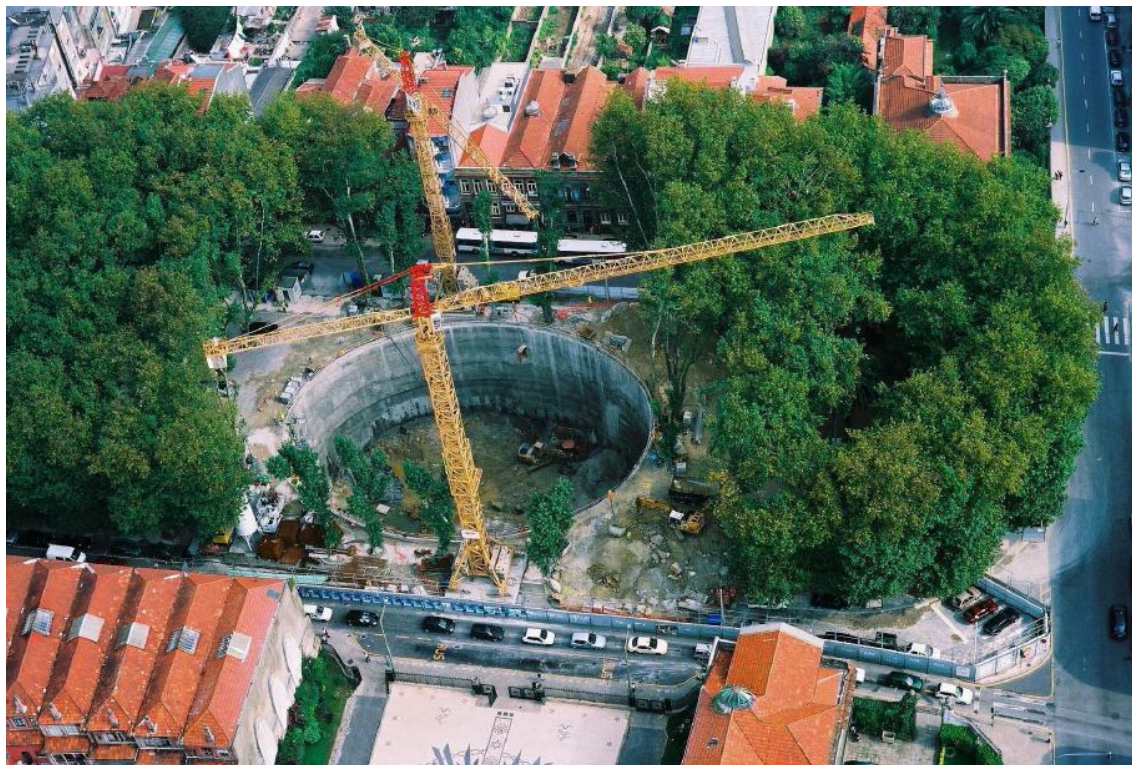
Fig. 14: Vista aérea da escavação da estação do Marquês
