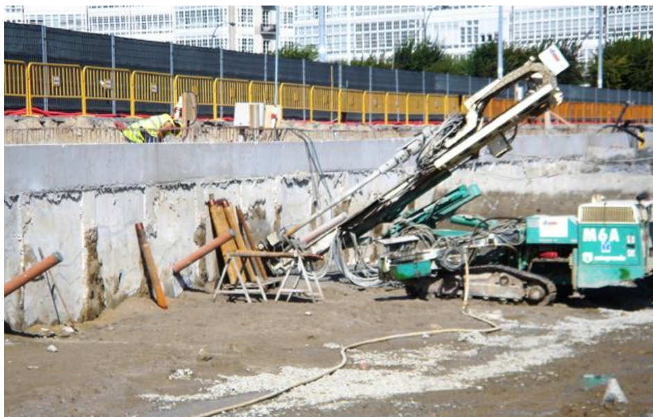
Fig. 11: Máquina a realizar ancoragens ( www.tecnogeo.pt )
