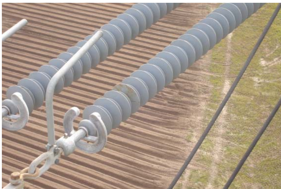
Figura 5.6 Cadeia de amarração dupla com isoladores compósitos em serviço (fonte: REN).
