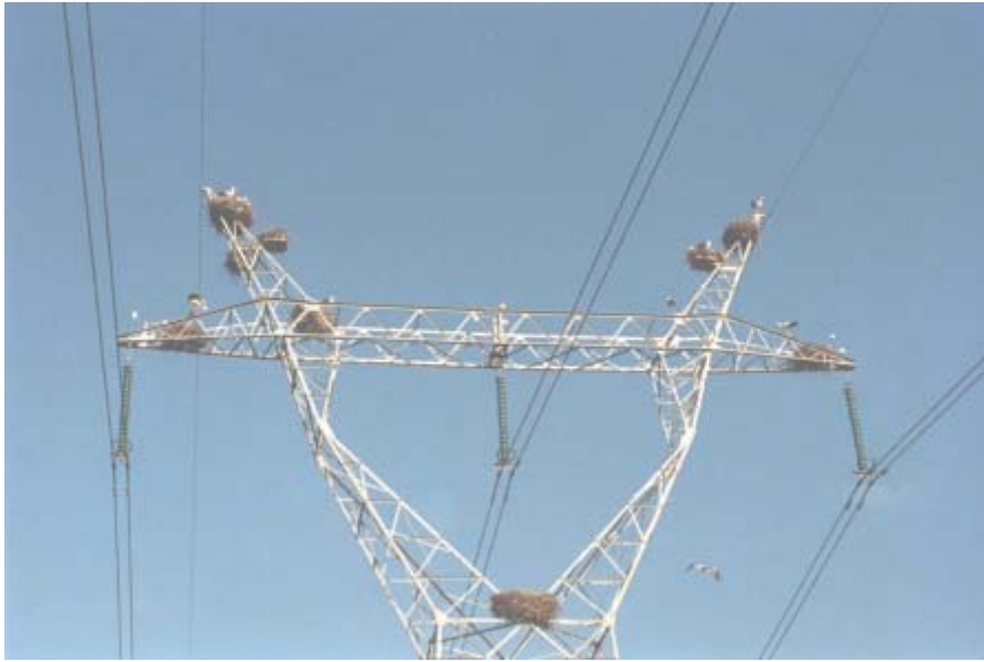
Figura 6.1 Apoio de linha de 400 kV em zona de forte nidificação da cegonha branca.
