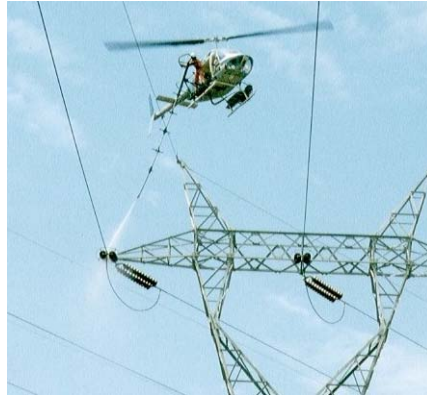
Figura 5.2 Lavagem de isoladores a alta pressão com meios aéreos.
