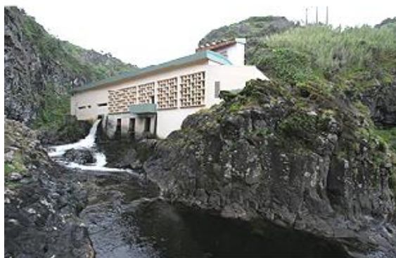
Figura 3.5 - Central Termoeléctrica/Hídrica de Além Fazenda
