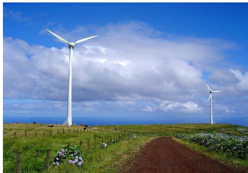
Figura 3.6 - Parque Eólico de Boca da Vereda.
