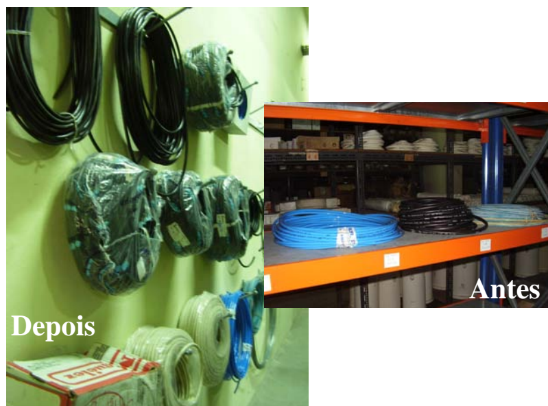
Figura 22 – Contraste entre a forma de armazenagem de cabos antes e depois do projecto
