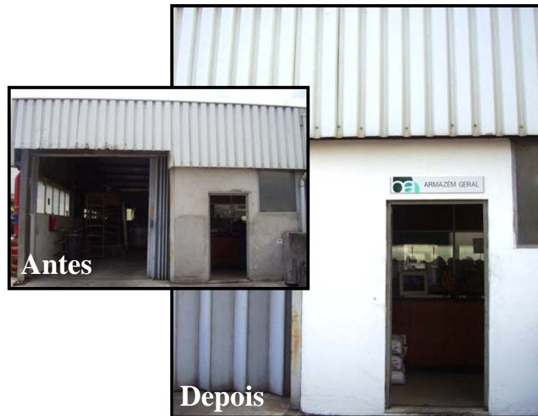
Figura 17 – Entrada do armazém geral de Avintes antes e depois do projecto
