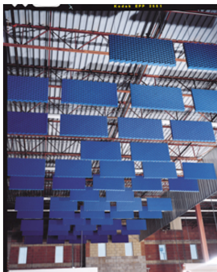
Fig. 2.11 - Exemplo de aplicação de absorsores suspensos (Baffles) (imagem retirada da marca comercial UNGER Technologies).
