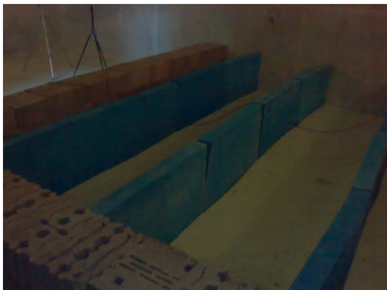
Fig. 5.42 – Colocação dos Baffles de Aglomex Acoustic “pintado” dentro da barreira não absorvente com D=1,0 m.
