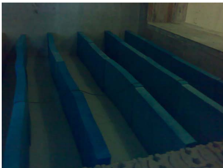
Fig. 5.43- Colocação dos Baffles de Aglomex Acoustic “pintado” dentro da barreira não absorvente com D=0,6 m.
