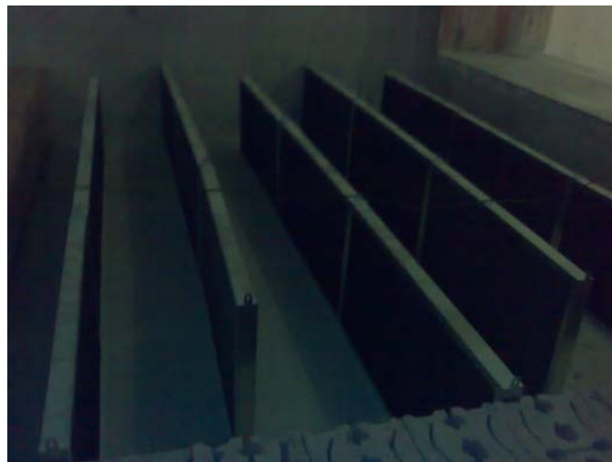
Fig. 6.8 – Colocação dos Baffles da SILÊNCIO dentro da barreira não absorvente com D=0,6 m.
