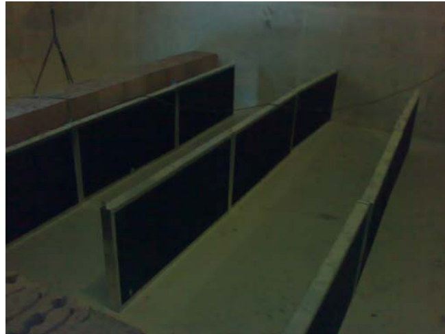
Fig. 6.7 – Colocação dos Baffles da SILÊNCIO dentro da barreira não absorvente com D=1,0 m.
