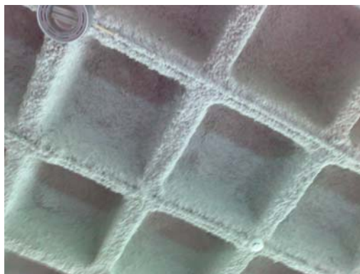
Fig 2.8 – Tecto com fibras projectadas.
