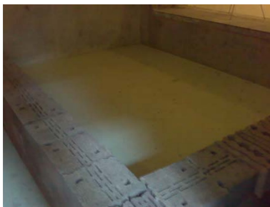
Fig. 5.39 – Montagem “ em poço” efectuada com tijolos.
