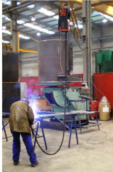
Figura 23: 1ª Fase de soldadura de um tramo cabine
