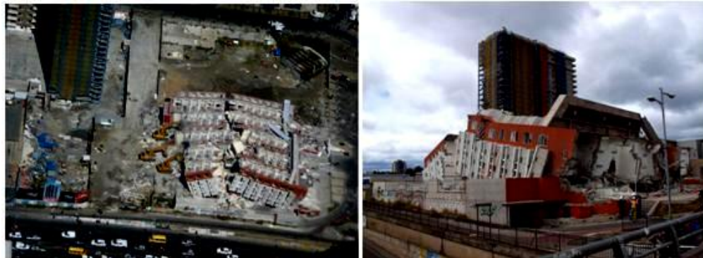
Figura 2. 4 - Proximidade dos edifícios e representação do colapso da torre construída [6]
