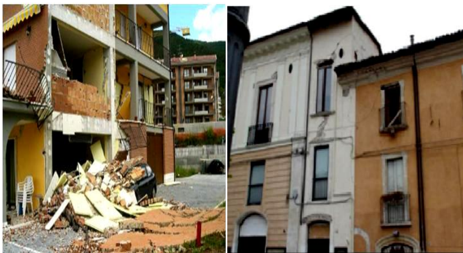
Figura 2. 6 - (a) Colapso de painel de alvenaria em edifício de betão armado [10] (b) Efeito de pounding entre edifícios de contíguos com altura irregular [9]
