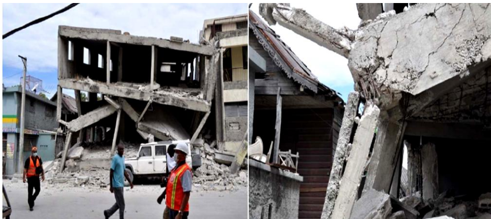
Figura 2. 11 – Vigas fortes por oposição a pilares fracos e de dimensões insuficientes [2]
