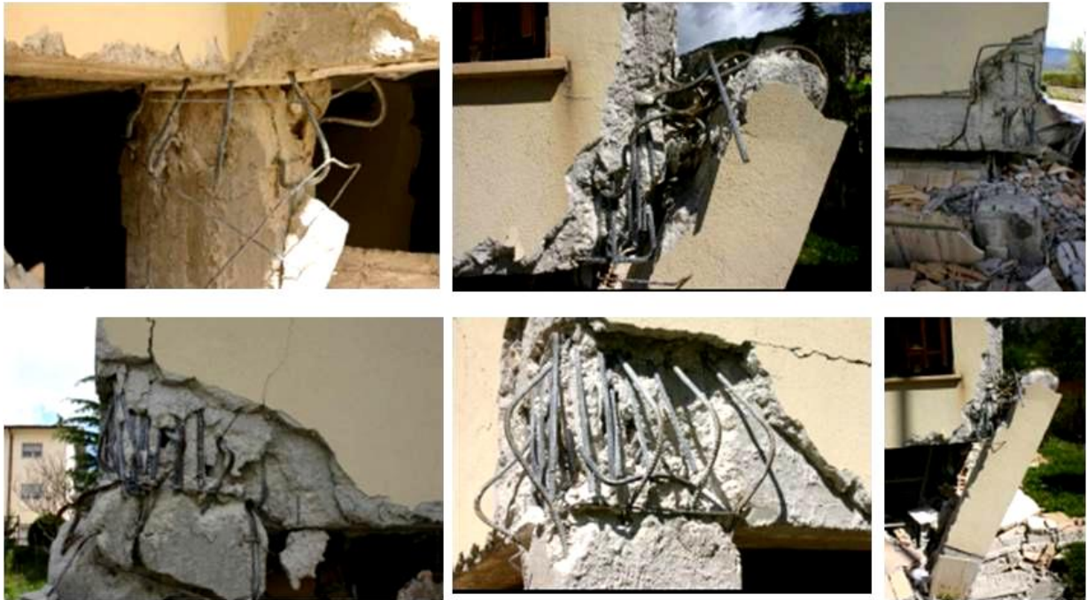
Figura 2. 15 – Características dos nós de ligação dos pilares às vigas [10]
