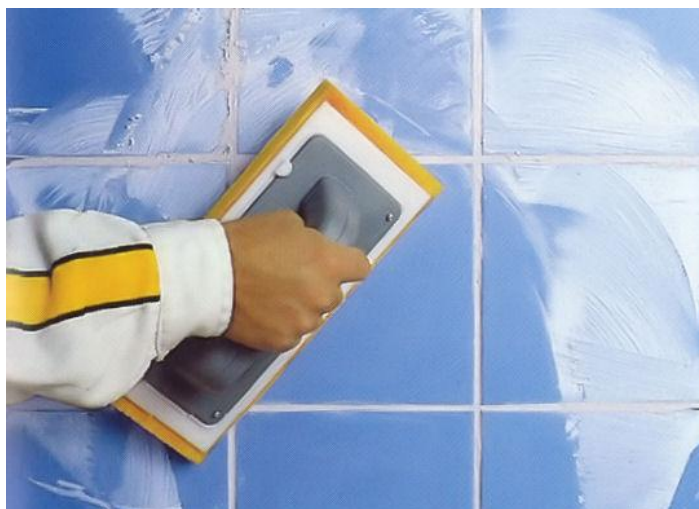
Figura 5.20 – Limpeza do material sobranete de juntas [7]
