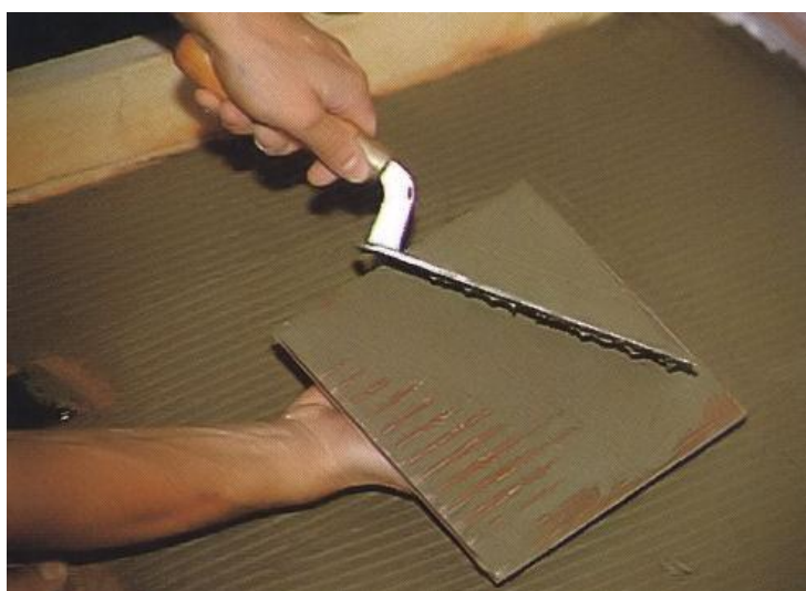
Figura 5.17 – Assentamento com colagem dupla de um ladrilho [7]
