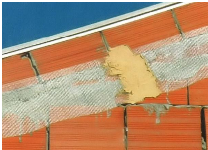
Figura 5.11 – Aplicação em obra da fibra de vidro [7]
