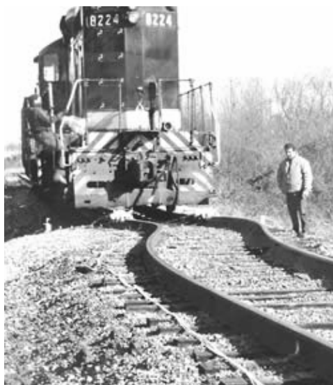
Figura 1.2 – Fenómeno de encurvadura na via-férrea ( http://www.dot.gov/ )
