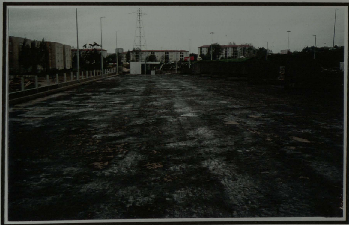
Figura 26 - APLICAÇÃO DA REGA DE COLAGEM
