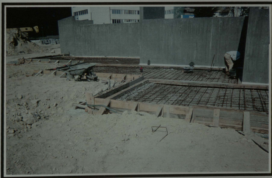
Figura 8 - MONTAGEM DE COFRAGEM NAS LAJES DE APOIO DOS CONTENTORES
