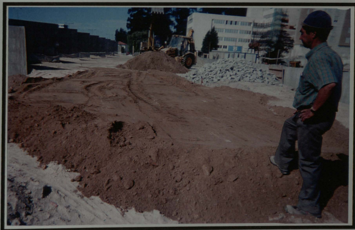
Figura 24 - COMPACTAÇÃO DO ATERRO
