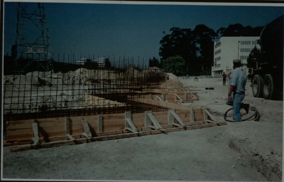
Figura 3 - PREPARAÇÃO DAS SAPATAS PARA OS MUROS CAIS
