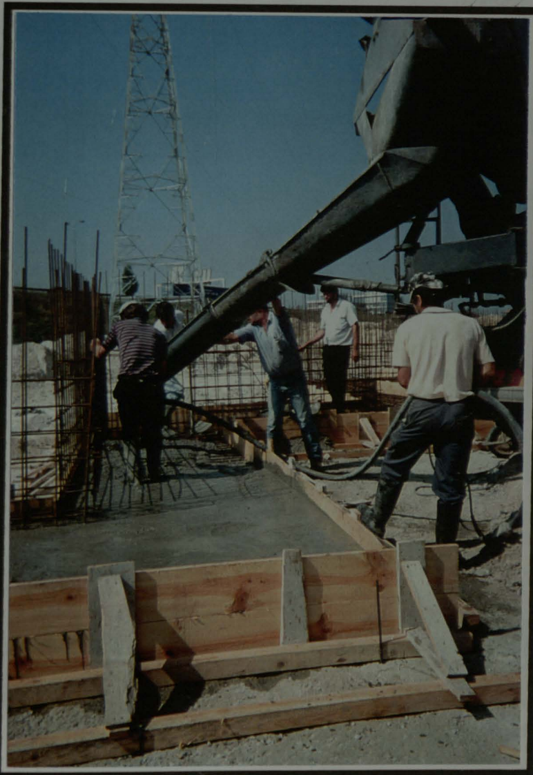
Figura 3 - PREPARAÇÃO DAS SAPATAS PARA OS MUROS CAIS
