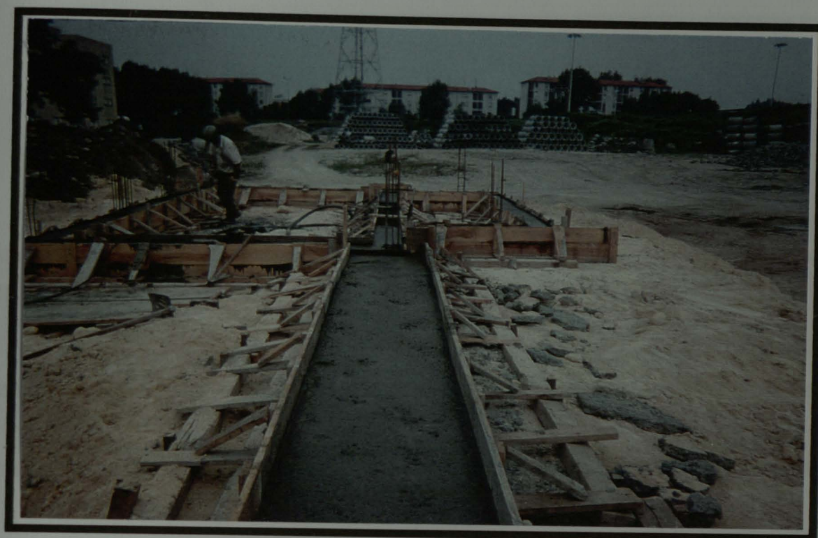
Figura 13 - BETONAGEM DOS LINTÉIS DO EDIFÍCIO DE RECEPÇÃO
