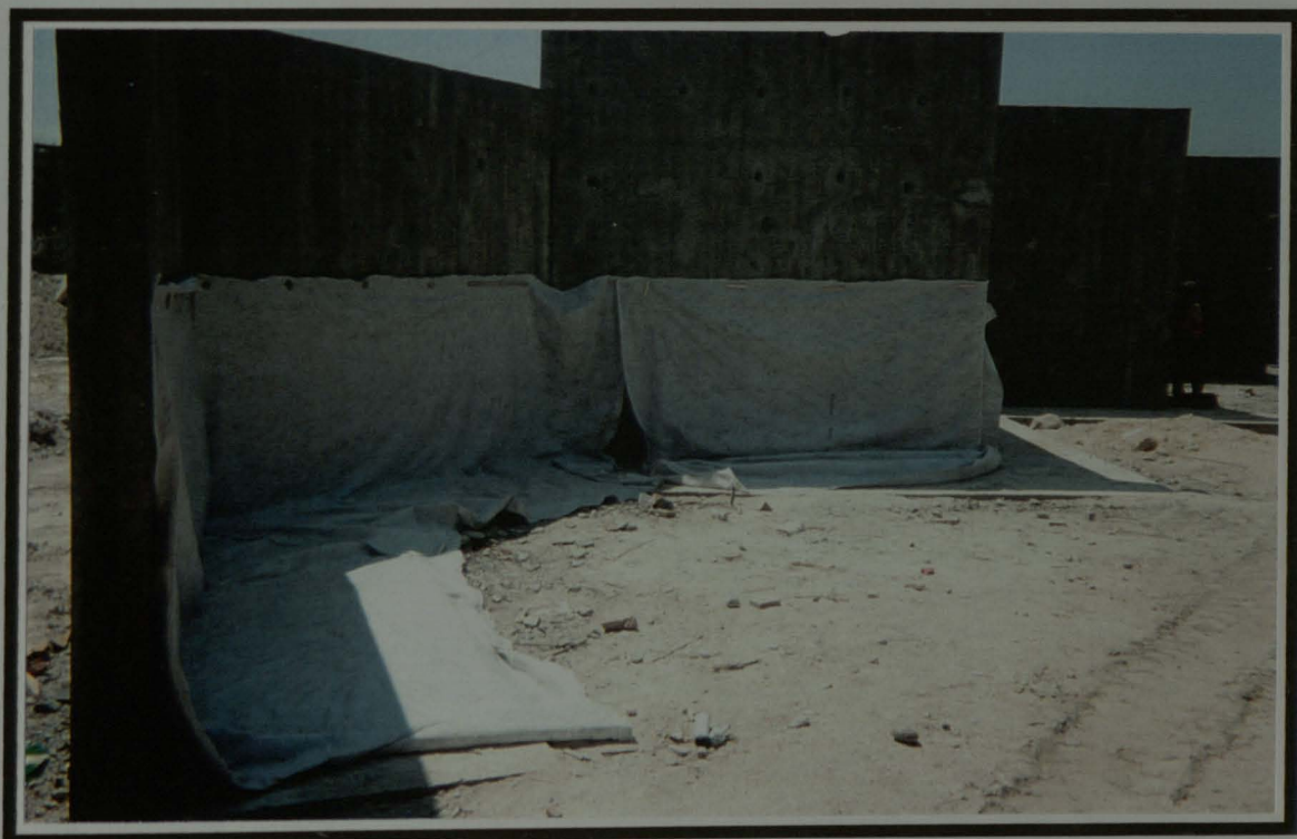
Figura 10 - APLICAÇÃO DE GEOTEXTIL NO TARDOZ DOS MUROS
