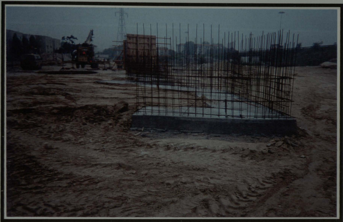
Figura 5 - COFRAGEM DOS MUROS CAIS
