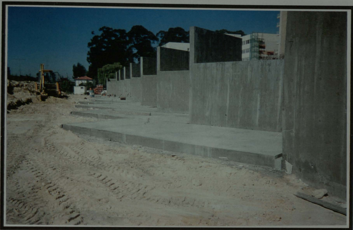
Figura 9 - DESCOFRAGEM DAS LAJES DE APOIO DOS CONTENTORES
