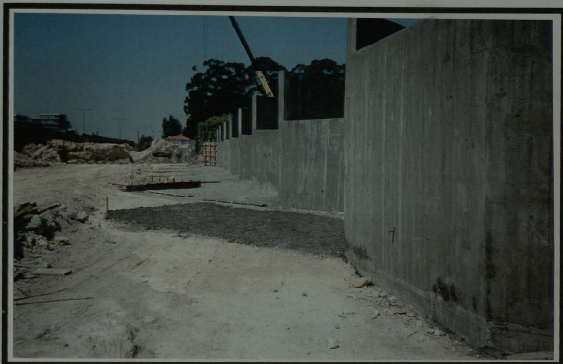
Figura 7 - APLICAÇÃO DE BETÃO DE LIMPEZA NAS LAJES DE APOIO DOS CONTENTORES
