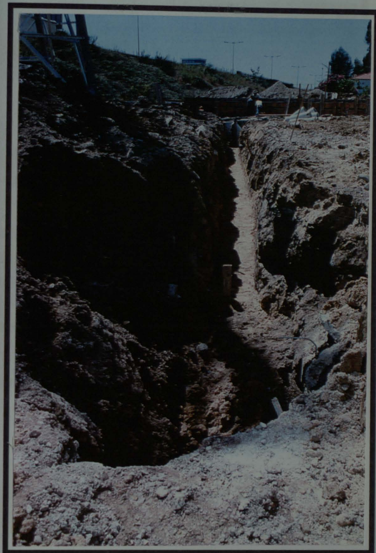
Figura 17 – ABERTURA DE VALA PARA COLECTORES
