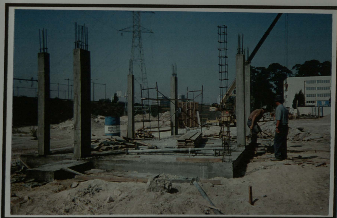
Figura 14 - VISTA GERAL DOS PILARES E DOS LINTÉIS DO EDIFÍCIO DE RECEPÇÃO
