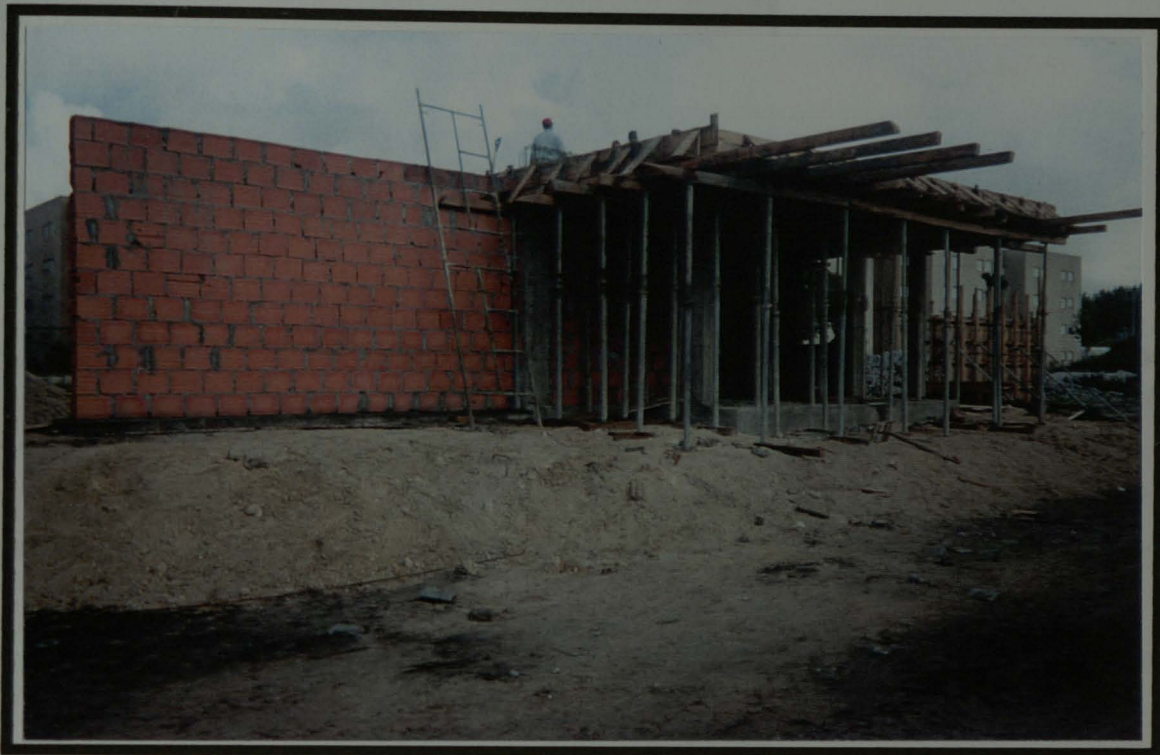
Figura 15 - BETONAGEM DA LAJE DO EDIFÍCIO DE RECEPÇÃO
