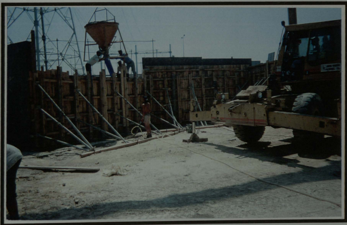
Figura 6 - BETONAGEM DOS MUROS CAIS
