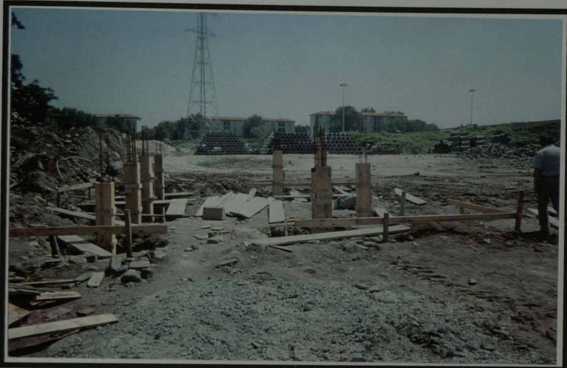
Figura 11 - PREPARAÇÃO DA BETONAGEM DOS PILARES DO EDIFÍCIO DE RECEPÇÃO
