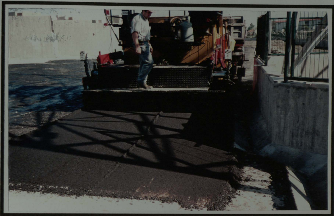
Figura 27 - APLICAÇÃO DA CAMADA DE DESGASTE DO PAVIMENTO
