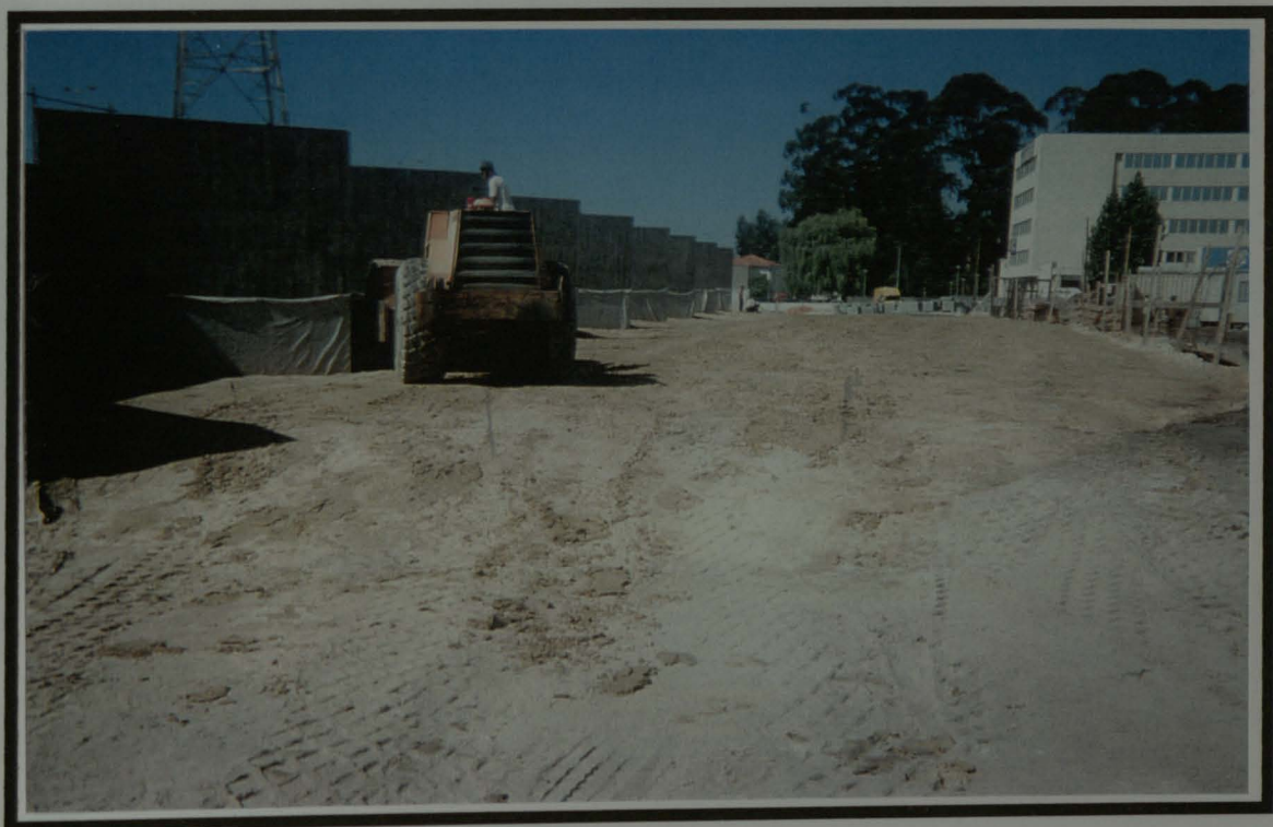
Figura 22 - COMPACTAÇÃO DO ATERRO
