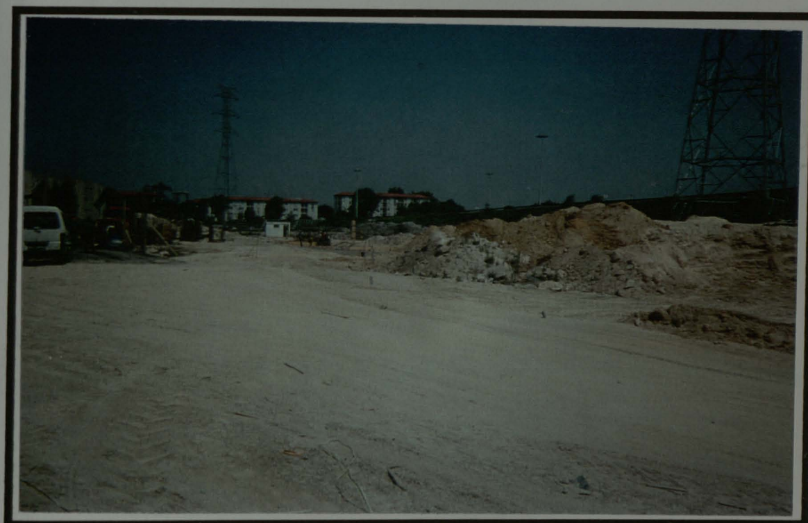
Figura 2 - TERRENO PARA EXECUÇÃO DO ECOCENTRO
