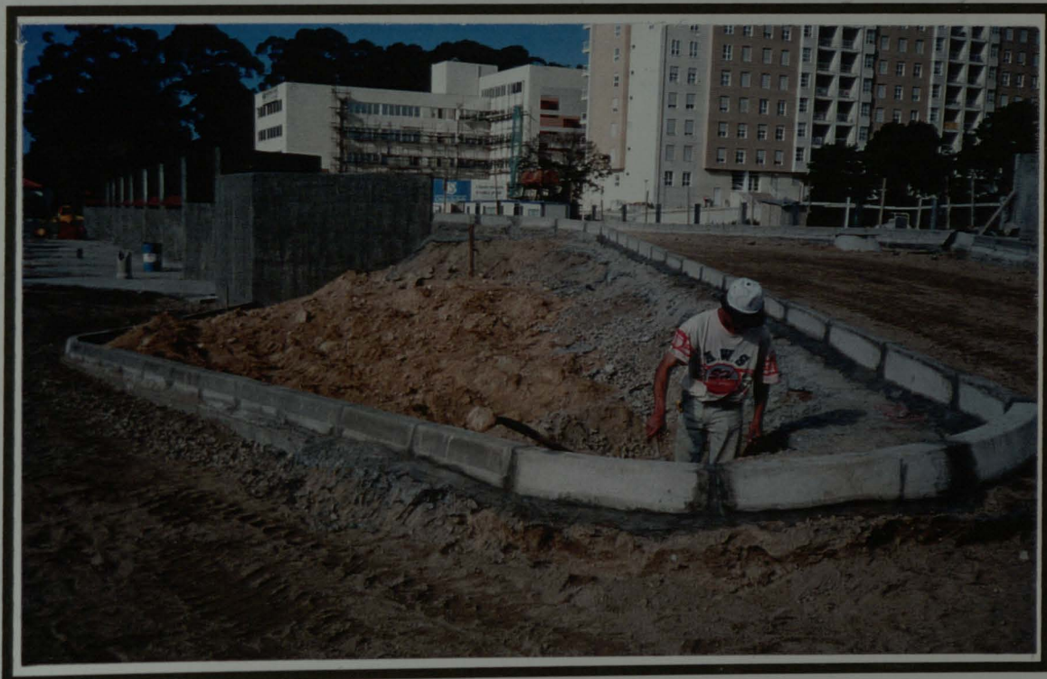
Figura 20 - COLOCAÇÃO DE LANCIS
