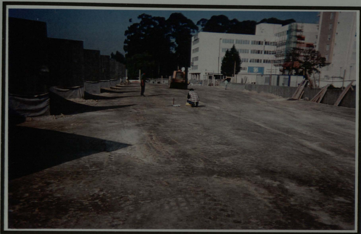
Figura 23 - EXECUÇÃO DOS ENSAIOS DE COMPACTAÇÃO
