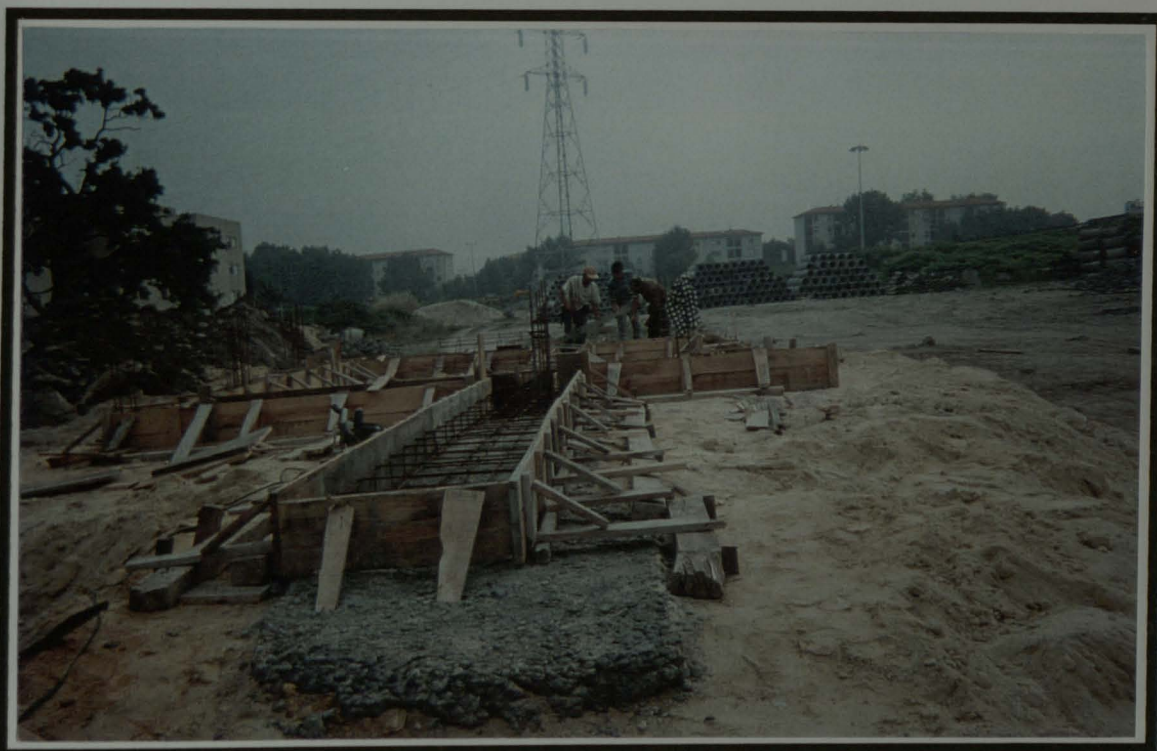
Figura 12 - CONSTRUÇÃO DA COFRAGEM DOS LINTÉIS DO EDIFÍCIO DE RECEPÇÃO
