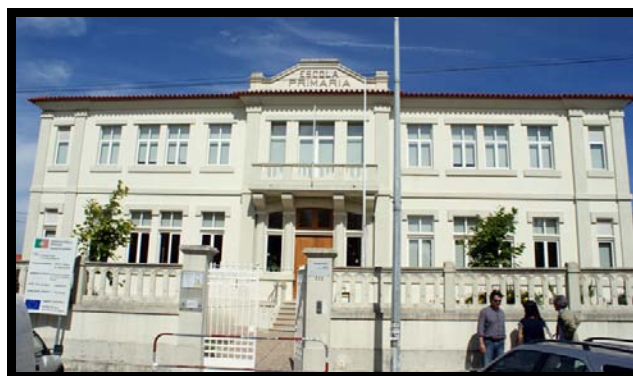
Fig.11 – Entrada dum estabelecimento escolar requalificado (Portugal)
