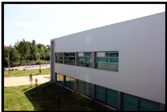
Fig.35 – Exterior centro escolar (Vila Verde)
