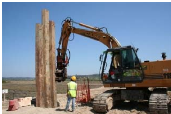
Figura 6 – Cravação dos perfis metálicos
