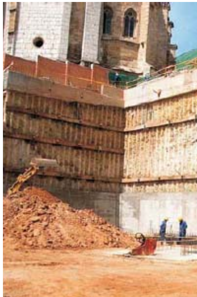
Figura 8 – Cortina de estacas moldadas ( http://www.terratest.es/ )
