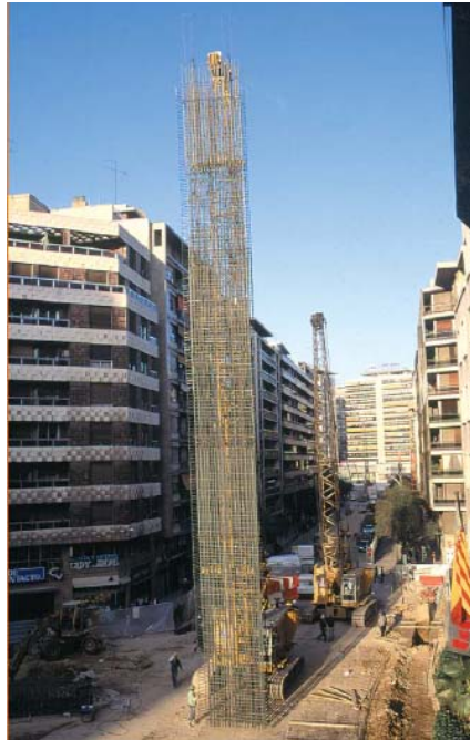
Figura 16 – Armadura da parede moldada
