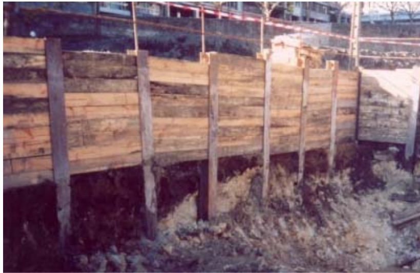
Figura 2 – Cortina tipo Berlim usada como contenção provisória (Matos Fernandes, 2004)
