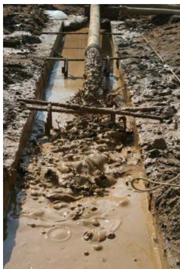
Figura 14 – Introdução de lama bentonítica na trincheira ( http://w4-web188.nordnet.fr/es/fs_accueil.html )
