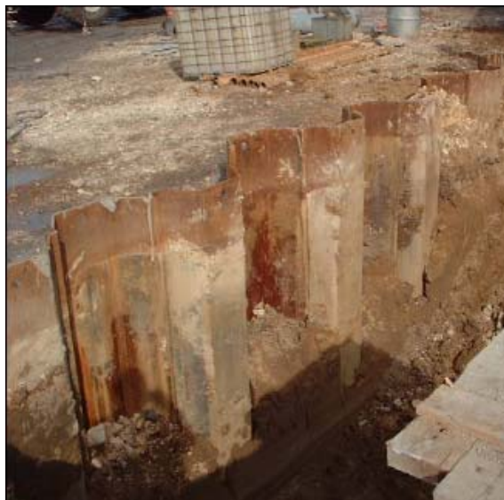
Figura 7 – Cortina de estacas-prancha cravadas à cota de projecto formando uma cortina contínua
