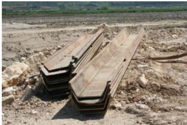
Figura 5 – Perfis metálicos tipo Larssen
