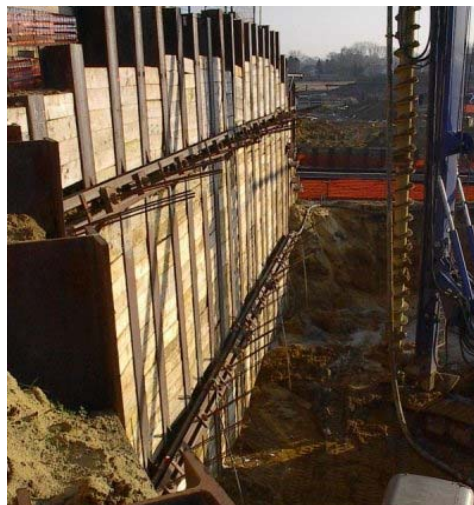
Figura 3 – Cortina tipo Berlim multiapoiada ( http://www.franki-geotechnics.be/ )
