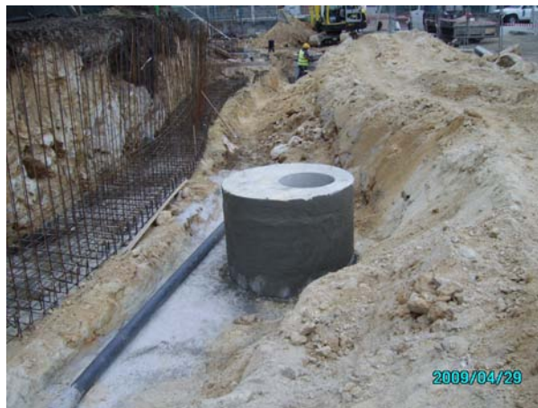
Fig. 3.25 – Caixa em execução de laje plana, cerzitada no lado exterior [21]
