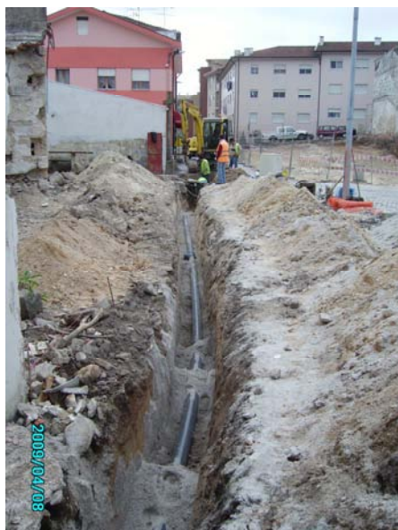
Fig. 5.1– Pormenor da aplicação de conduta distribuidora em vala [21]
