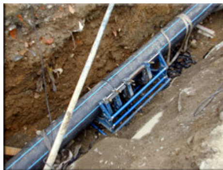
Fig. 3.5 – Tubagem de PEAD em vala [12]
