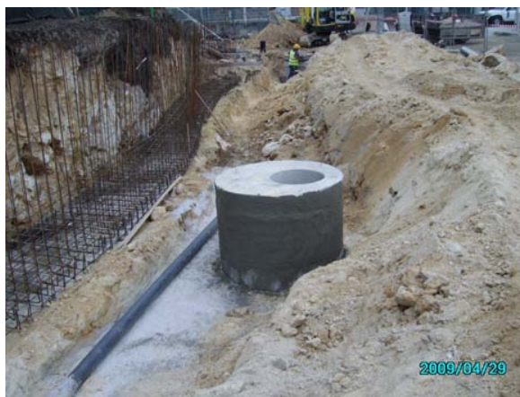
Fig. 5.2– Pormenor da execução da caixa da rede de águas residuais [21]
