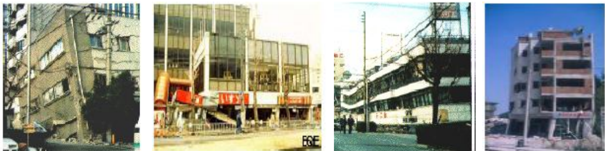
Fig.2.4 – Mecanismos de soft-storey devido a pisos sem painéis de alvenaria (Varum, 2003)
