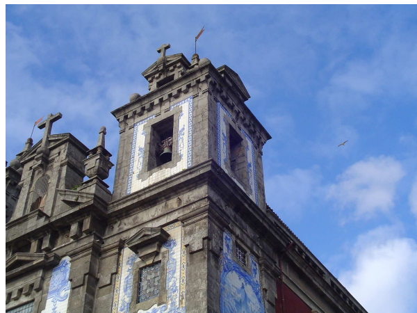
Figura 3.10 – Torre sineira onde foi colocado o segundo aparelho de medição
