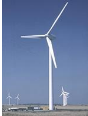
Figura 1.6 - Representação de um aerogerador de rotor com eixo horizontal [8].
