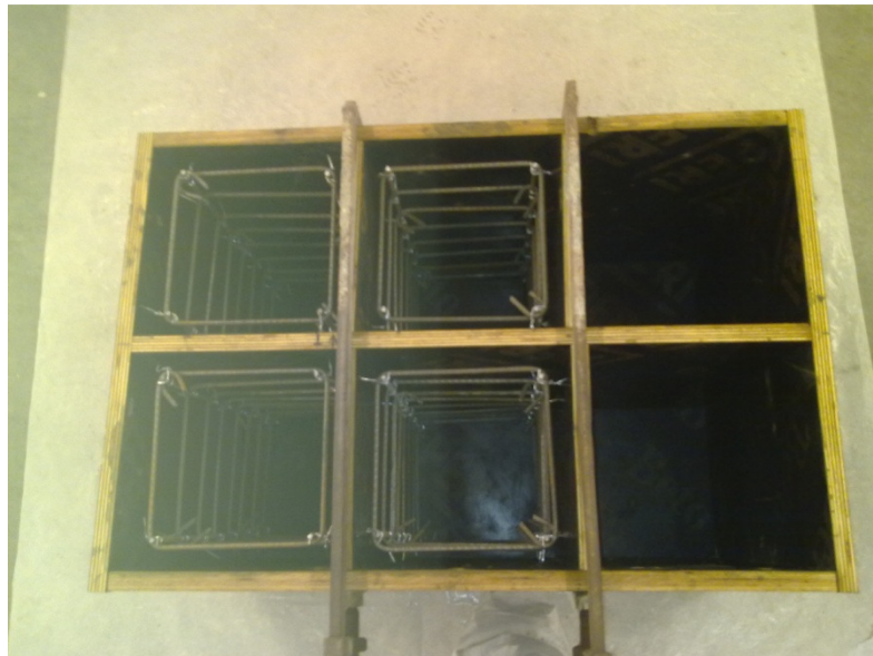
Fig. 5.12 – Cofragem e colocação das armaduras
