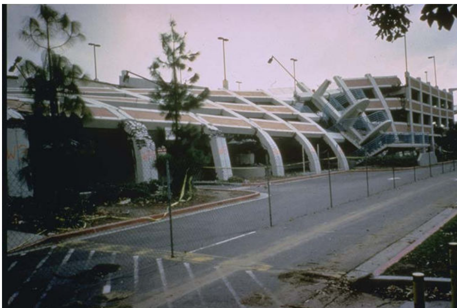
Fig. 2.14 – Rotura de uma estrutura sujeita ao sismo de Northridge em Los Angeles, em 1994
