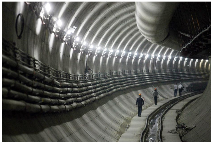
Fig. 2.15 – Imagem de um túnel do metro de São Paulo na fase de construção
