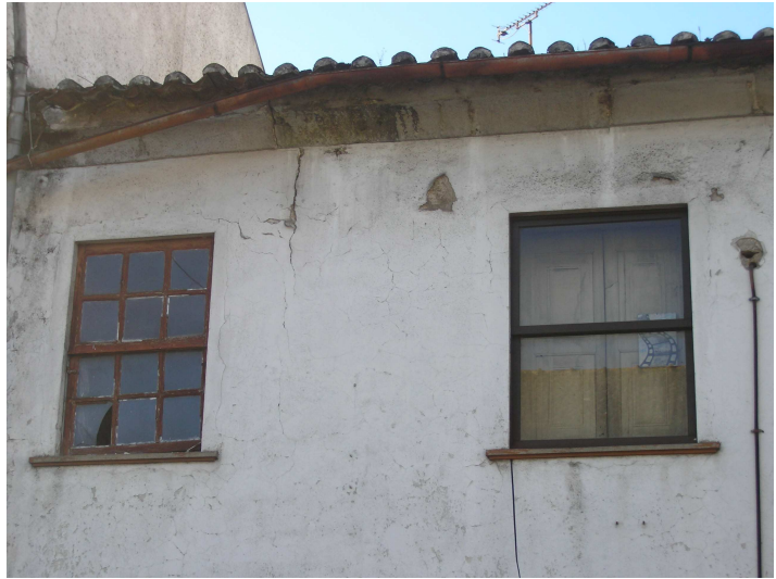
Fig.21 – Caixilharia de madeira do tipo guilhotina, Marco de Canaveses
