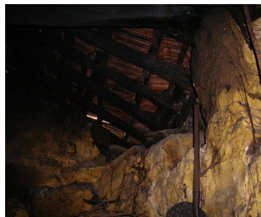
Fig.15 – Cobertura antiga revestida a telha cerâmica, Marco de Canaveses
