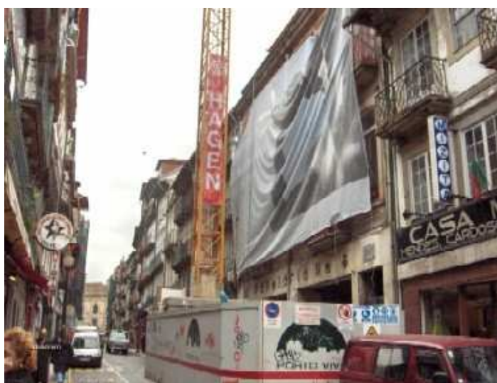
Fig.7 – Primeira obra de reabilitação da SRU do Porto, n.º 150 da Rua das Flores, (Fonte [11])
