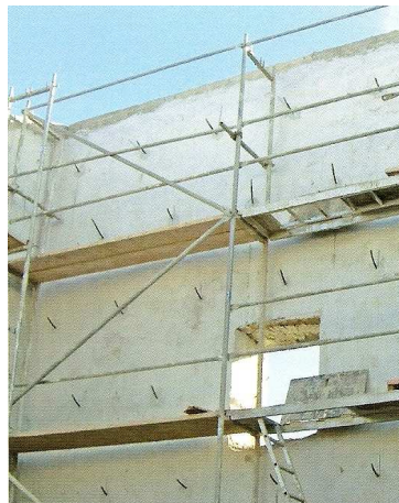
Fig.38 – Injecções de consolidação em paredes de alvenaria de pedra, (Fonte [31])
