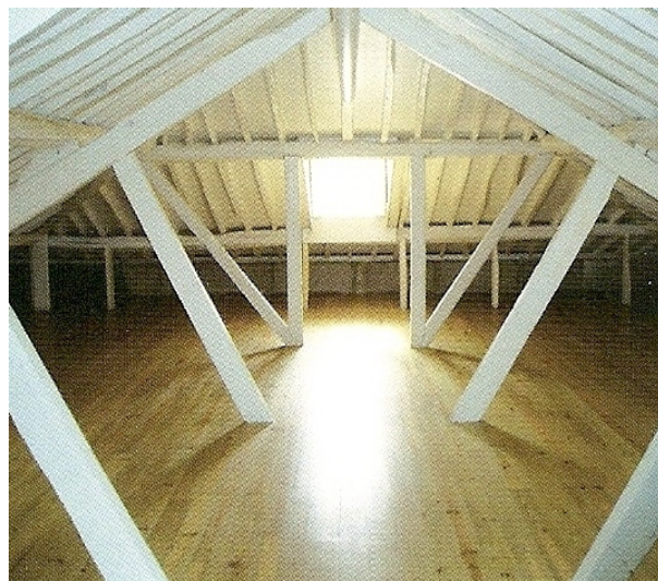
Fig.43 – Estrutura de cobertura reabilitada, (Fonte [31])
