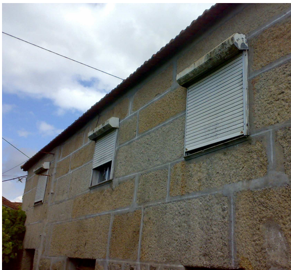
Fig.22 – Protecção solar exterior de persiana, Marco de Canaveses
