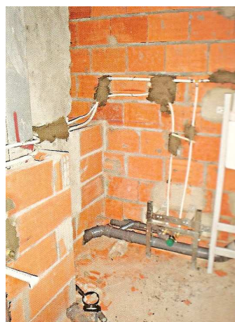
Fig.47 – Reabilitação de um fogo com substituição de instalação de distribuição de água, (Fonte [31])
