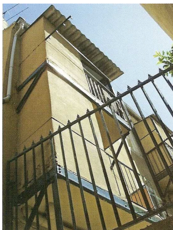
Fig.29 – Lisboa, São Mamede, construção de prumadas sanitárias no espaço das varandas, (Fonte [31])
