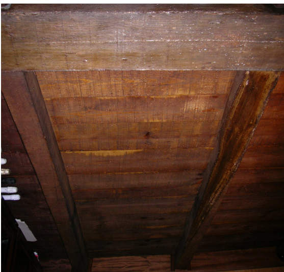
Fig.42 – Estrutura de pavimento reabilitada, Marco de Canaveses
