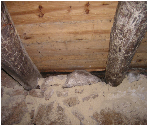
Fig.16 – Apoio do vigamento principal na parede de alvenaria, Marco de Canaveses
