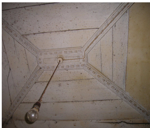
Fig.14 – Forro de uma cobertura antiga, Marco de Canaveses
