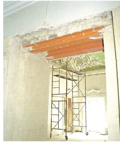
Fig.36 – Utilização de perfis metálicos para reforço de parede em zona de abertura de vão, (Fonte [31])
