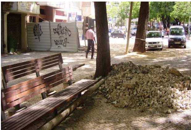
Fig.57 – Vedação em mau estado e materiais depositados no espaço público sem qualquer sinalização, (Fonte [32])
