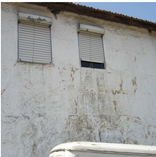
Fig.11 – Alvenaria ordinária, Marco de Canaveses
