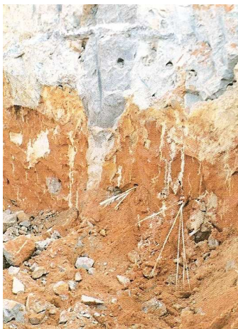
Fig.33– Aspecto do solo reforçado com “jet-grouting”, (Fonte [31])
