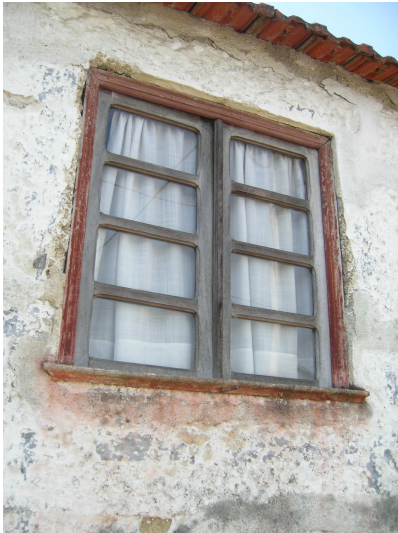
Fig.20 – Caixilharia de madeira do tipo batente, Marco de Canaveses
