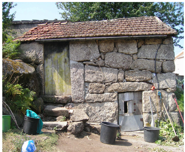
Fig.12 – Alvenaria de pedra seca ou insossa, Marco de Canaveses
