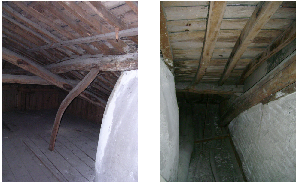
Figura 4.8 e 4.9: Vistas interiores do desvão da cobertura.
