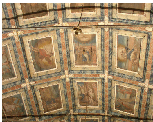
Figuras 2.5 e 2.6: Exemplos de tectos estucados e de caixotões de madeira.
