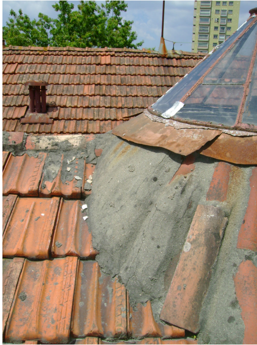
Figuras 2.7 e 2.8: Exemplos de excesso de argamassa.
