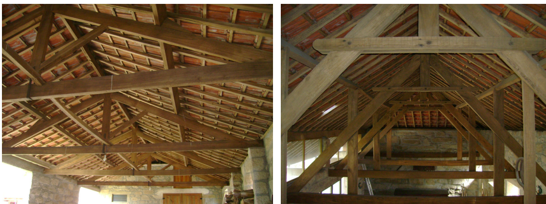
Figuras 2.3 e 2.4: Exemplos de diferentes composições estruturais das asnas.
