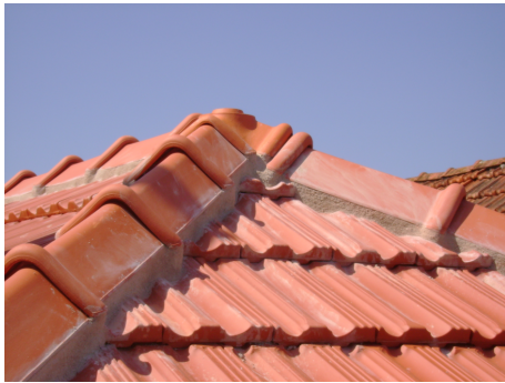
Figuras 2.7 e 2.8: Exemplos de excesso de argamassa.
