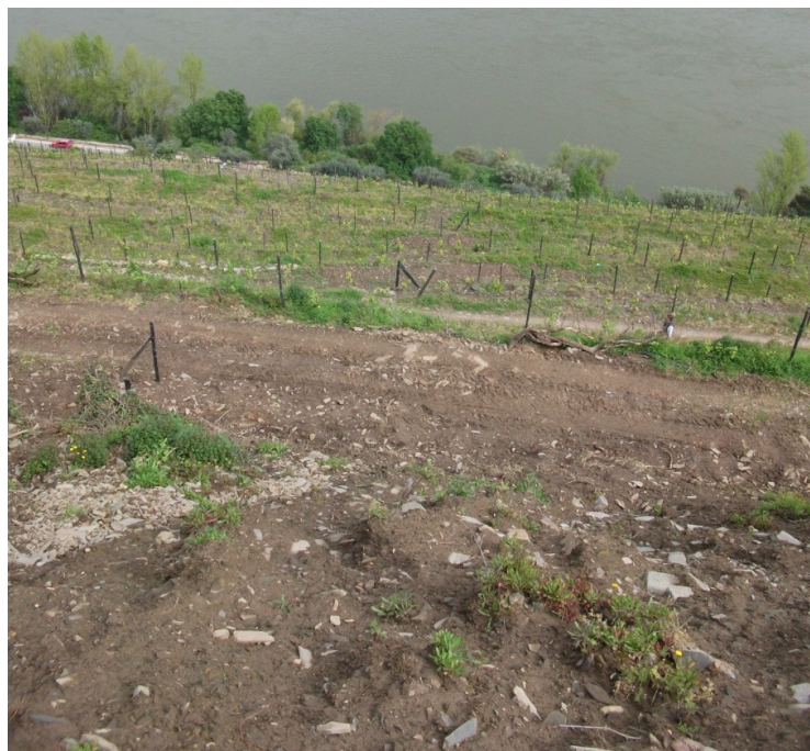
Fig. 3. 8 – Deslizamento numa encosta moldada em patamares.
