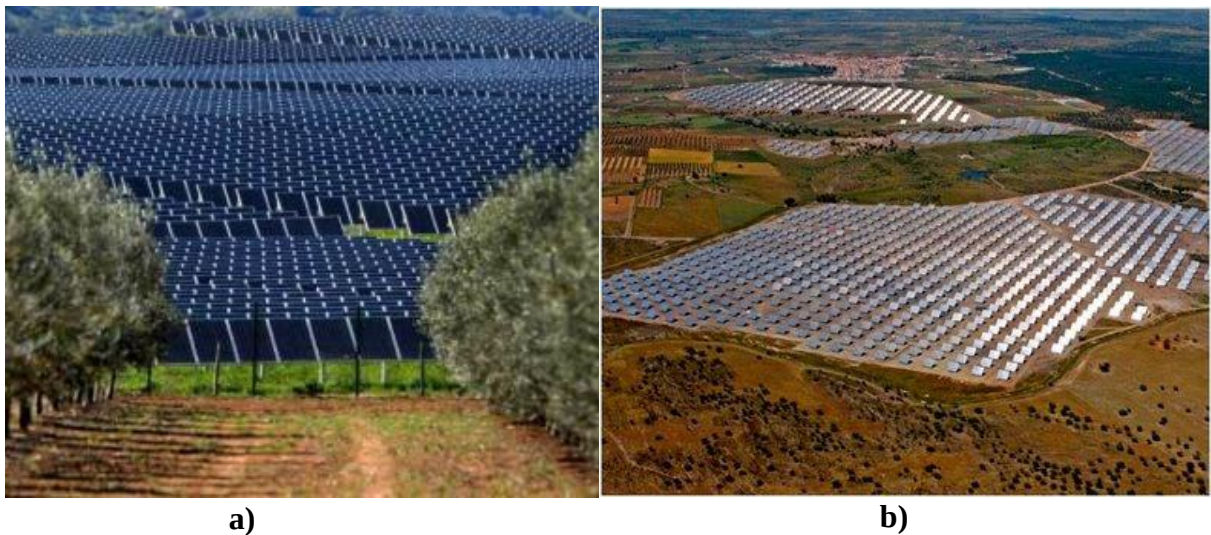
Figura 2.7: Central fotovoltaica de Moura [19],[20].
