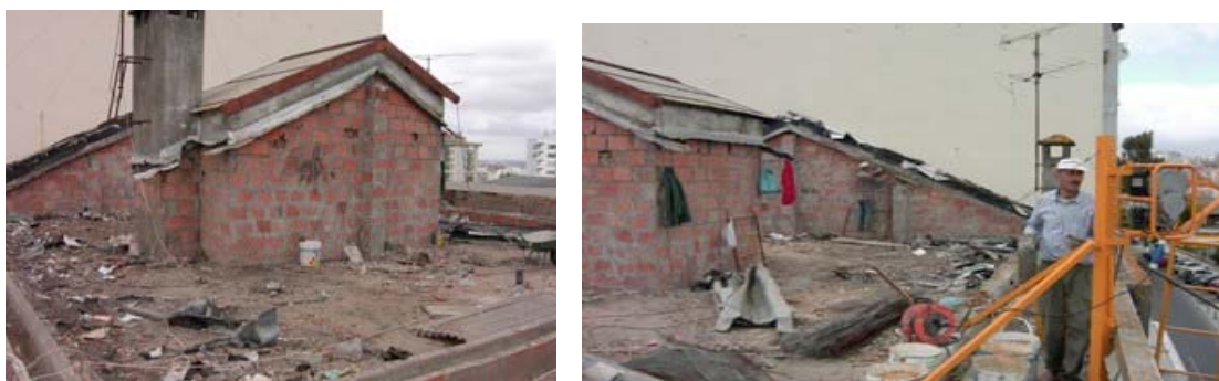
Figura 4.1 – Destruição de coberturas deterioradas para substituição completa
