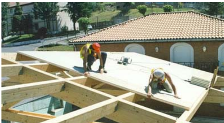
Figura 5.4 – Isolamento contínuo com painel sanduíche [25]
