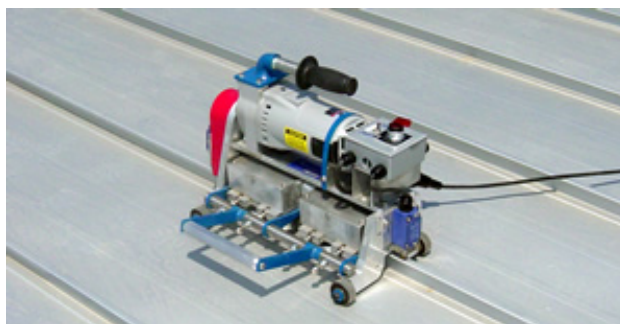
Figura 4.11 – Encaixes longitudinais das coberturas com sistema Roofzip [21]
