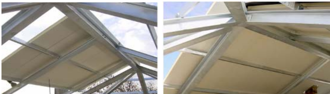
Figura 5.6 – Painel sanduíche – estrutura simples e leve [25]
