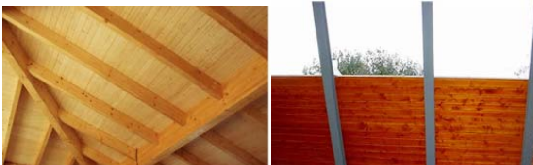
Figura 5.5 – Revestimento interior do painel sanduíche [25]
