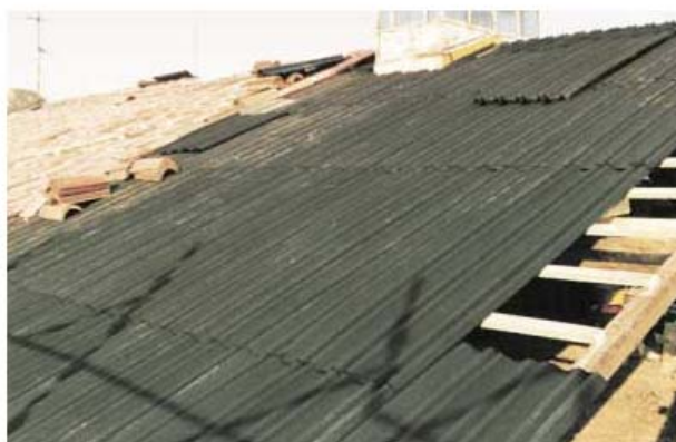
Figura 4.5 – Cobertura inclinada com subtelha [19]
