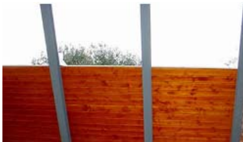
Figura 5.7 – Aplicação do painel sanduíche em estrutura metálica [25]
