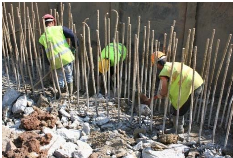
Figura 5.53 – Saneamento de uma cortina de moldada de betão armado, rebaixamento da linha de Espinho, 2007.
