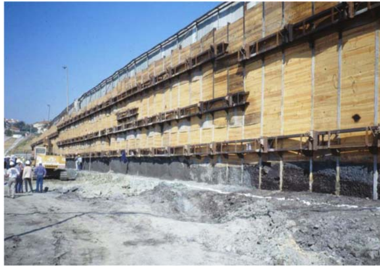
Figura 5.8 – Cortina tipo Berlim provisória ancorada (Guerra, 1999).
