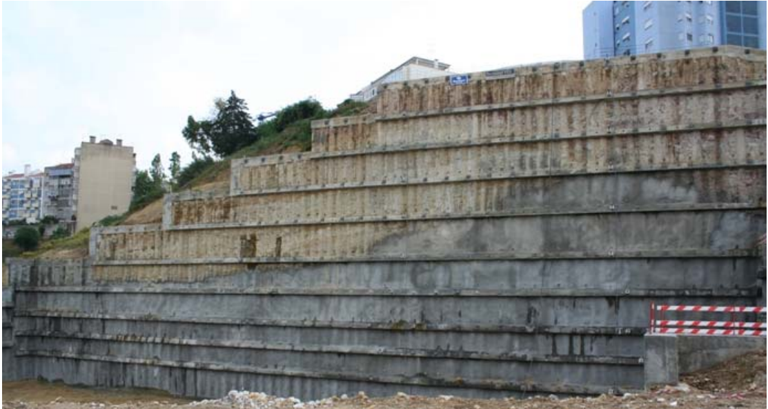
Figura 5.6 – Cortina de estacas espaçadas multiapoiada – Biblioteca central e arquivo municipal de Lisboa, 2007.
