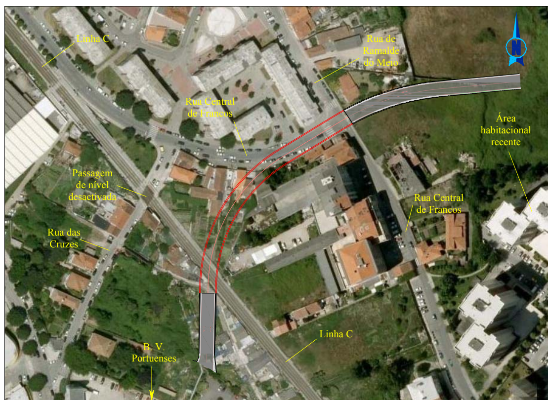
Figura 2.1 – Fotografia aérea da zona interessada pela obra (Google Earth, 2008).
