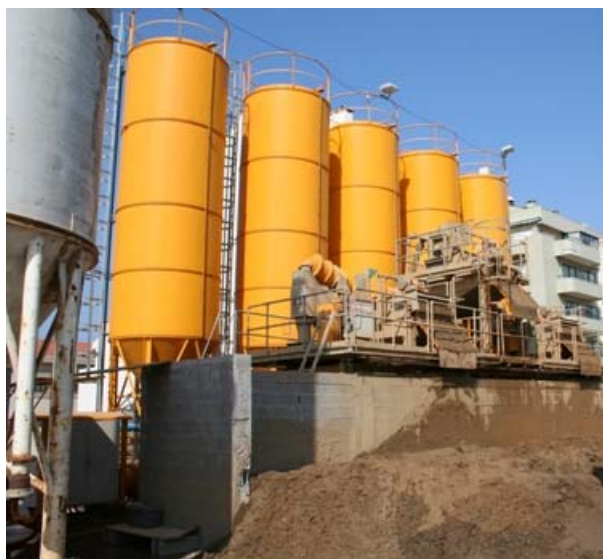
Figura 5.5 – Central de tratamento de lamas bentoníticas – Rebaixamento da linha de Espinho, 2007.
