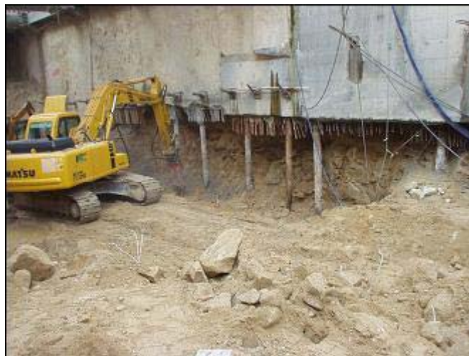
Figura 5.52 – Recalce de uma parede moldada na estação 24 de Agosto - Conceição et al. (2006).
