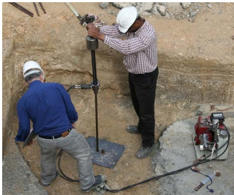
Figura 3.4 – Realização de um ensaio penetrométrico, 2007.
