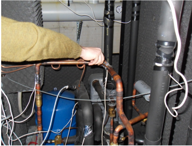
Figura 52 - Aplicação dos sensores de pressão.
