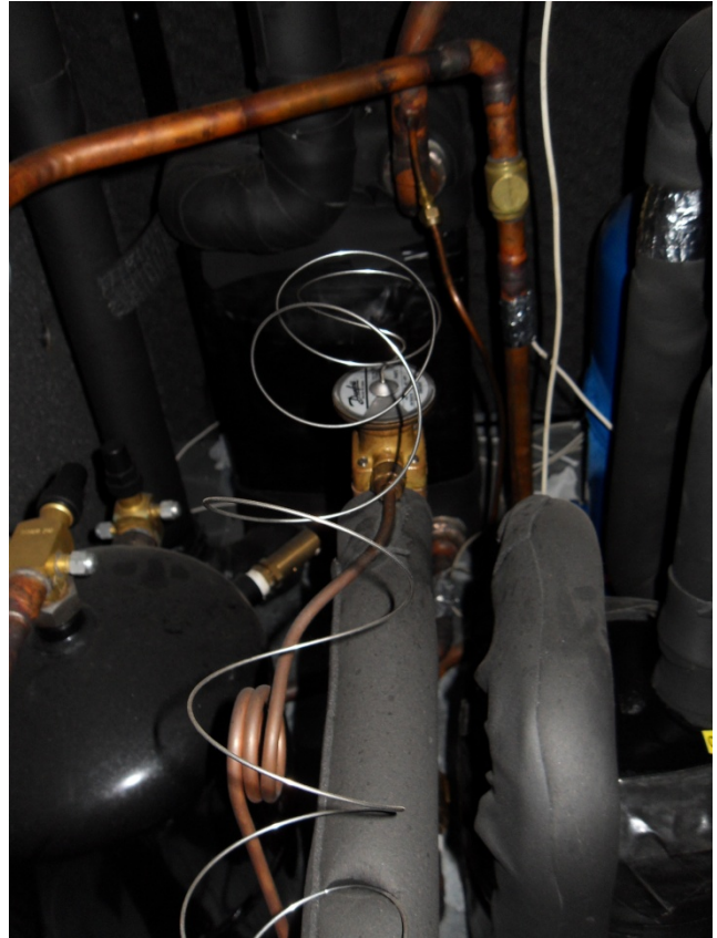
Figura 51 - Válvula de expansão.
