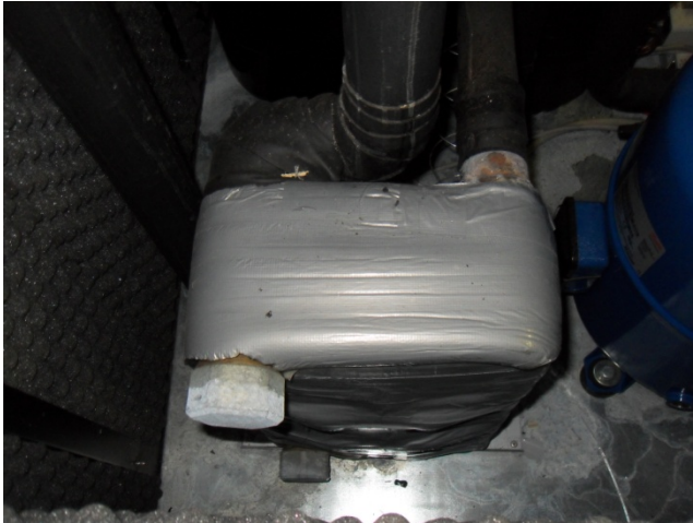
Figura 48 - Condensador.
