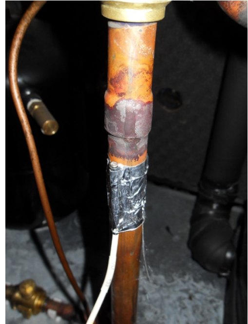
Figura 53 - Sensor de temperatura do lado da alta pressão.
