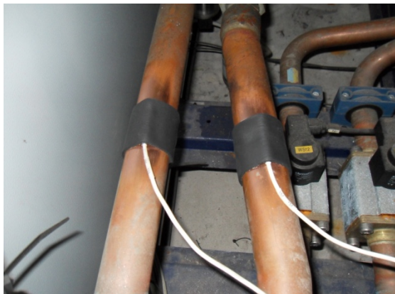
Figura 65 - Instalação dos sensores de temperatura.
