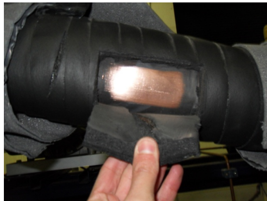
Figura 64 - Remoção do isolamento e lixagem para colocação de sensores.
