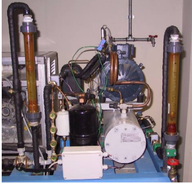
Figura 27 - Sistema de refrigeração laboratorial (vista lateral).
