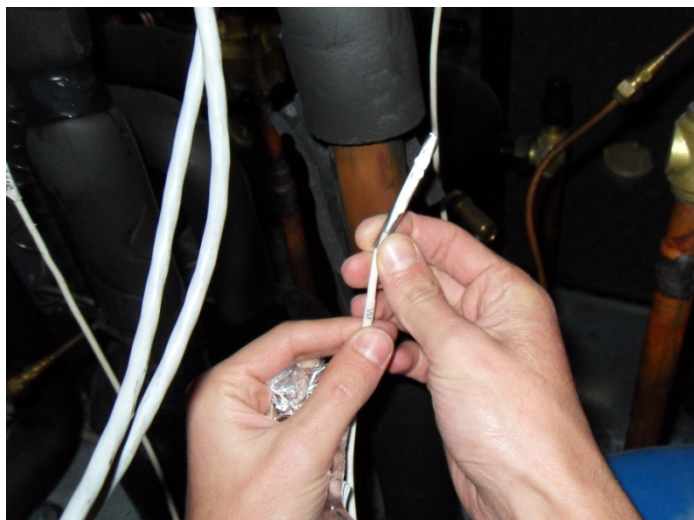
Figura 57 - Sensor de temperatura com massa térmica.
