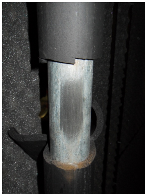
Figura 56 - Tubo com isolamento retirado e lixado.
