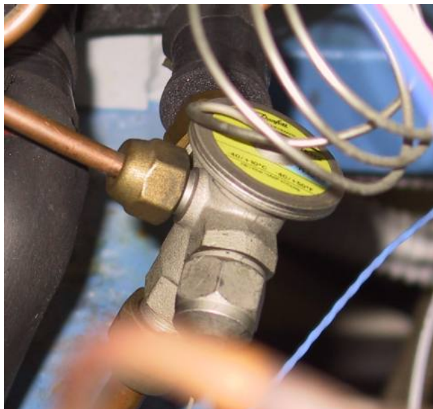
Figura 33 - Válvula de expansão.
