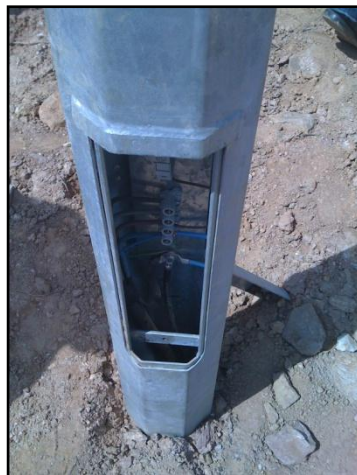
Figura 6.14 - Portilhola da coluna de iluminação normaliza (à esquerda) e não normalizada pela EDP Distribuição (à direita)
