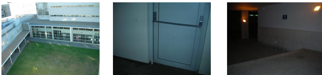
Figura 40 - Layout impede a escalada pelo exterior / Porta de emergência mantida aberta em baixo / Parque de bicicletas
