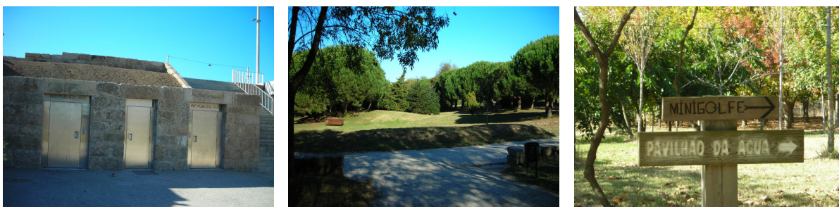
Figura 32 - WC Oeste trancada / Bifurcação sem sinalização / Sinalização parca
