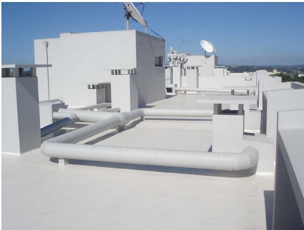
Fig. 3.1 – Imagem de uma cobertura impermeabilizada com sistema ‘não tradicional’
