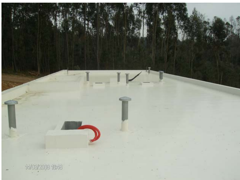
Fig. 4.1 – Cobertura de uma moradia com revestimento à base de poliuretano
