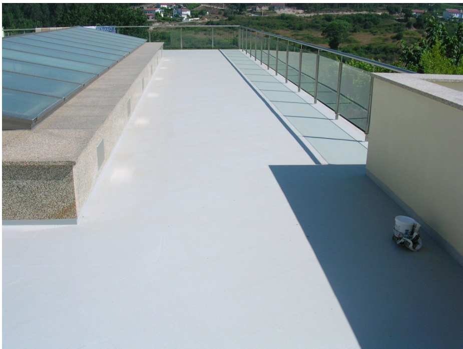
Figura 4.3 – Terraço com revestimento cimentício
