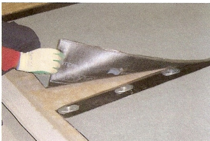
Fig. 3.3 - Aplicação da segunda camada de um sistema de camada dupla [70]
