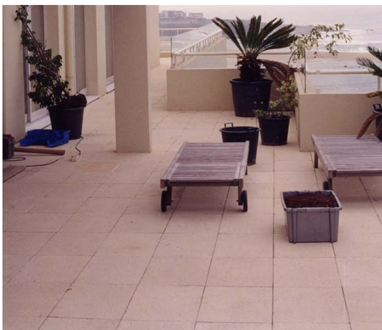
Figura 4.2 – Terraço com revestimento cimentício e acabamento cerâmico
