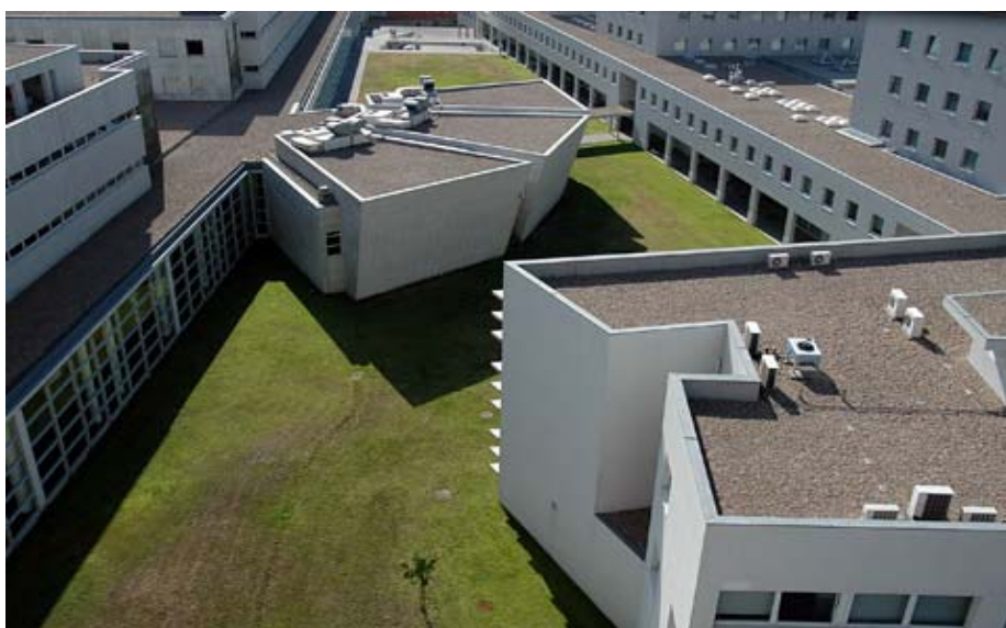
Fig. 1.1 – Cobertura Plana com utilização significativa
