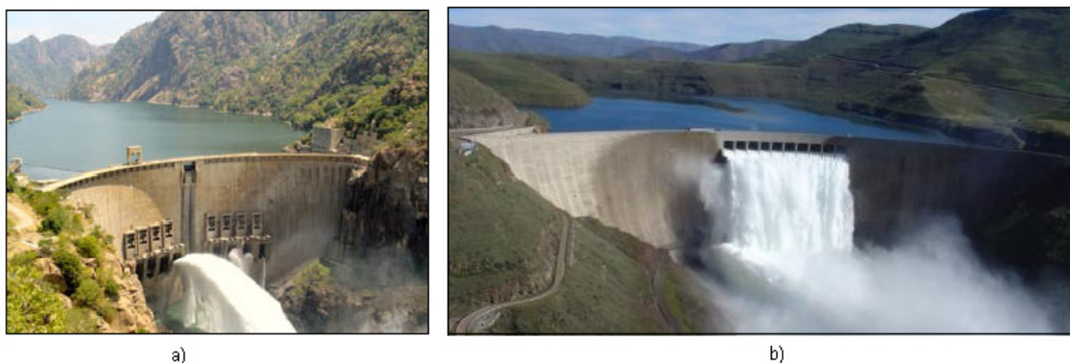
Fig.1.12. – Descarregadores de cheias inseridos no corpo da abóbada: a) – Barragem de Cabora Bassa [5]; b) – Barragem de Katse. [6]
