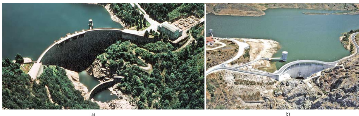
Fig.1.13. – Descarregadores de cheias inseridos no corpo da abóbada: a) – Barragem de Salomonde [3]; b) – Barragem do Caldeirão. [3]
