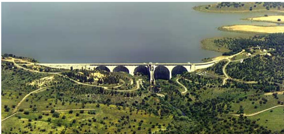
Fig.1.10. – Barragem de Odivelas. [3]
