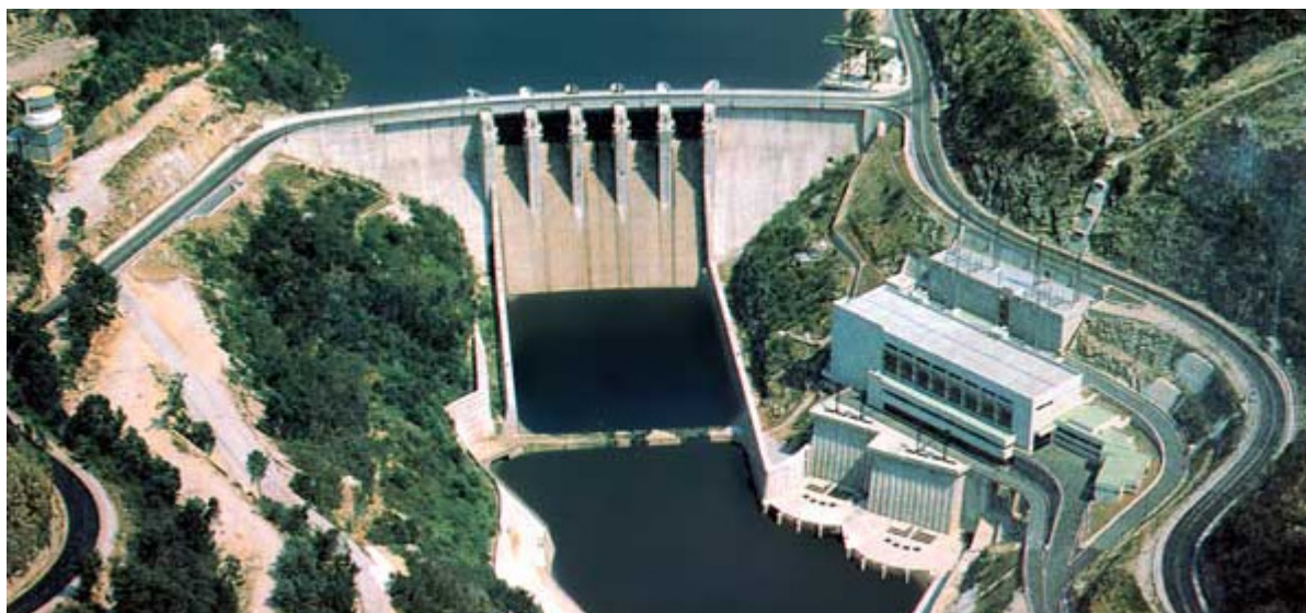
Fig.1.3. – Barragem do Torrão. [3]
