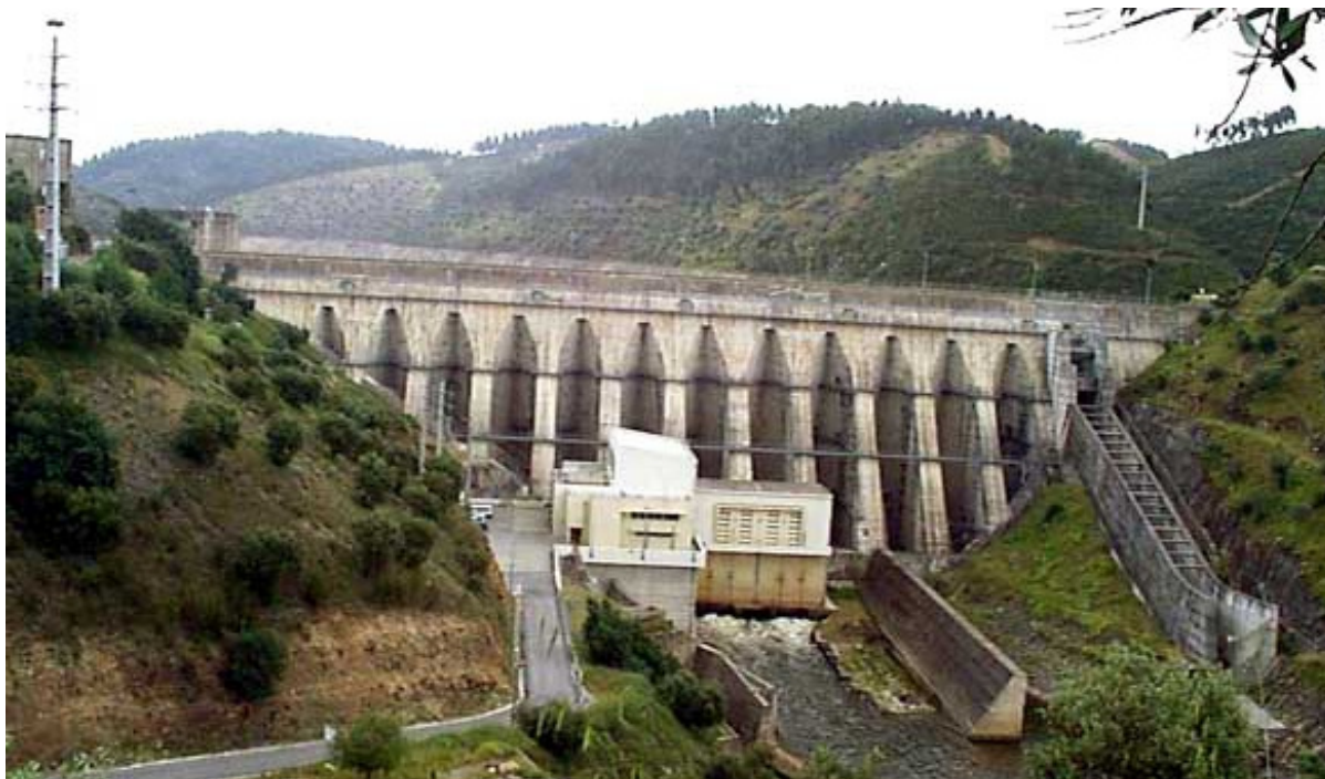
Fig.1.5. – Barragem de Pracana. [3]
