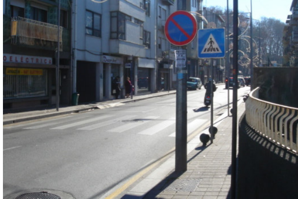
Fig. 18 - Poste de iluminação mal localizado (fraca visibilidade da passagem de peões).
