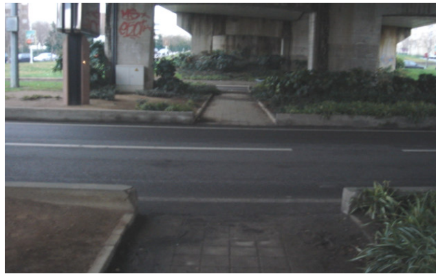
Fig. 21 - Aspecto de percurso pedonal incompleto (ausência de passagem de peões).
