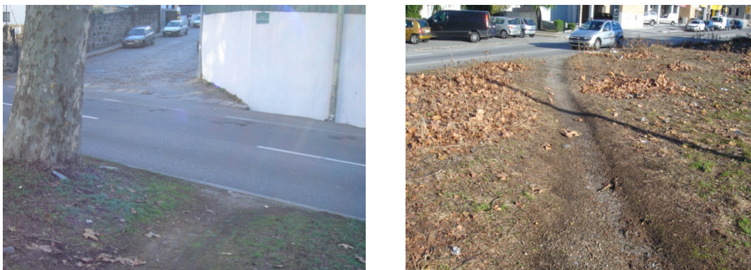
Fig. 15 - Aspecto de carreiros no separador central provocados pelo atravessamento de peões.
