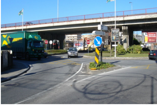
Fig. 20 - Fraca conservação das marcas rodoviárias.
