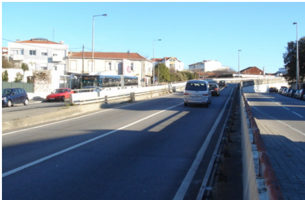
Fig. 13 - Aspecto da entrada poente do Viaduto da Areosa.
