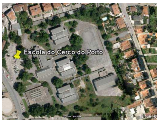
Fig.6.19 - Localização da obra
