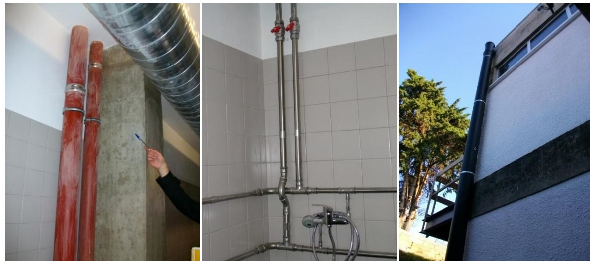
Fig.6.24. – Alguns tipos de instalações verificados
