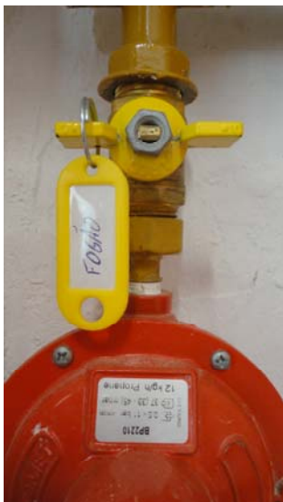
Fig. 5.18 – Válvula de corte do fogão
