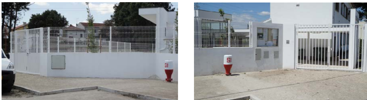
Fig. 5.6 – Marcos de incêndio
