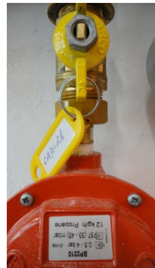
Fig. 5.20 – Válvula de corte da caldeira
