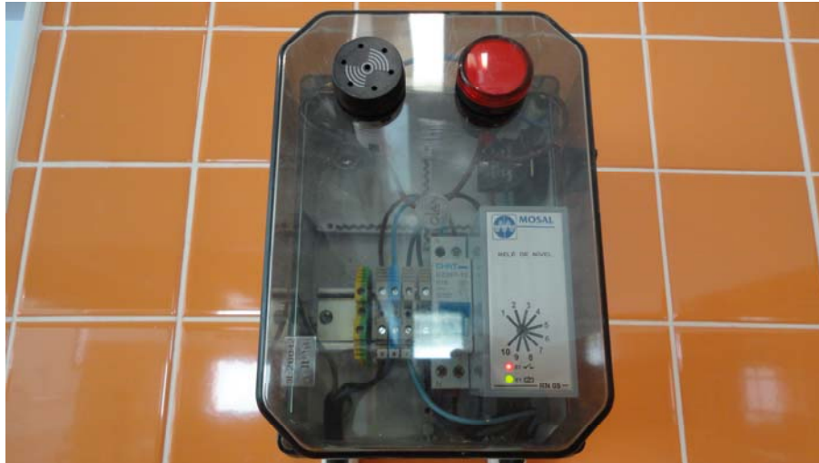
Fig. 5.25 – Detetor de gás combustível
