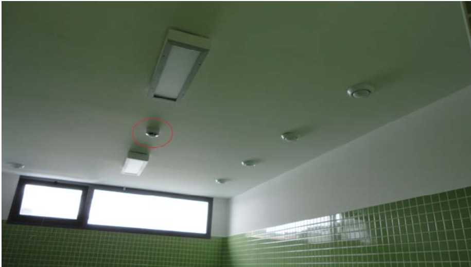
Fig. 5.23 – Detectores automáticos
