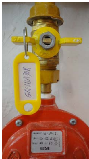
Fig. 5.19 – Válvula de corte do grelhador
