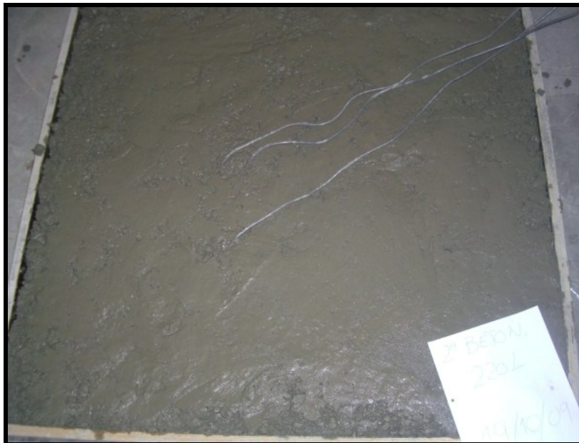
Fig. 21 – Molde da laje com betão fresco
