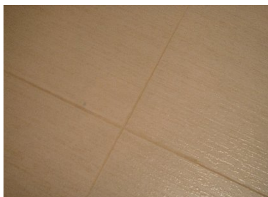
Fig.6.7 – Preenchimento das juntas
