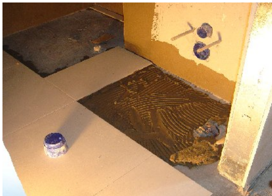
Fig.6.4 – Aplicação do cimento-cola
