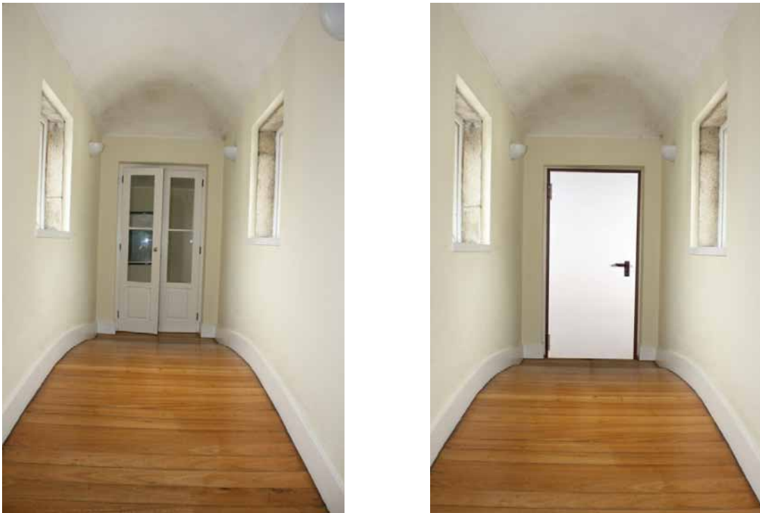
Fig. 4.30 e 4.31 – Situação actual e Montagem de uma possível solução para porta corta-fogo (compartimentação)
