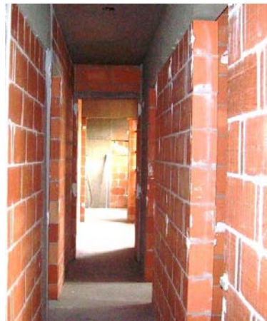
Fig. 2.1 – Paredes divisórias em tijolo furado
