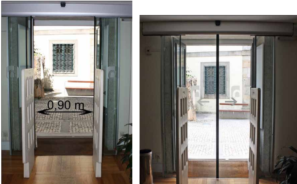
Fig. 4.42 e 4.43 – Porta principal motorizada (aberta e fechada com sinalização, respectivamente)
