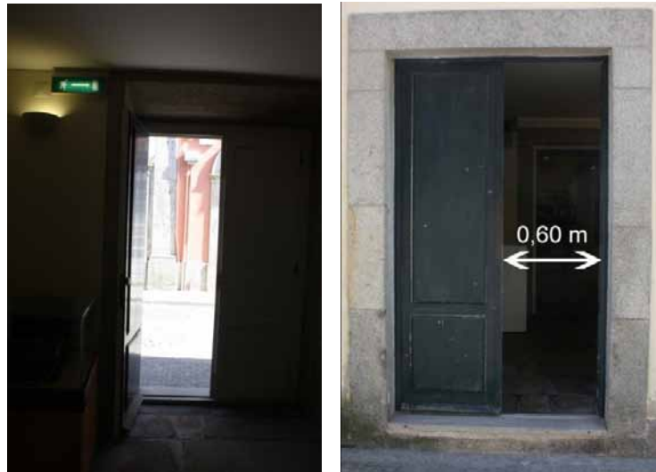
Fig. 4.37 e 4.38 – Porta Norte (Saída de emergência segundo a sinalização luminosa e largura da saída)
