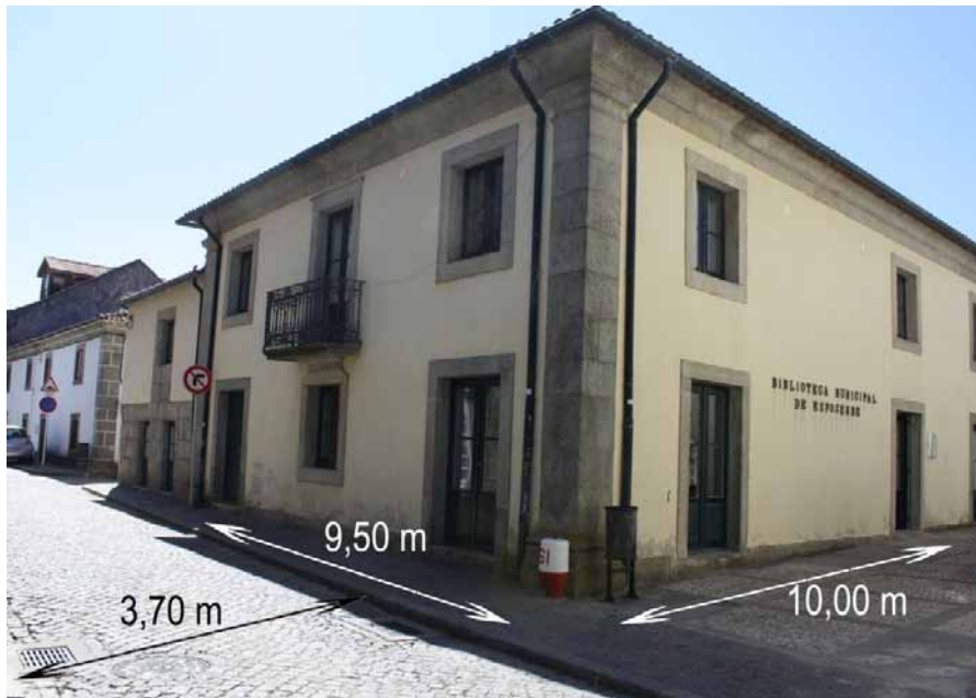
Fig. 4.28 – Via de acesso (Rua de Nossa Senhora da Saúde)
