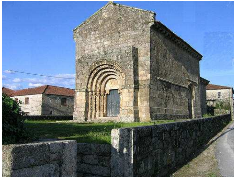
Fig. 3.1 – Fachada principal da igreja de Bravães [11]
