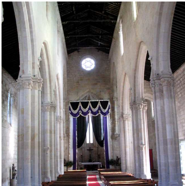
Fig. 12.2 – Interior da igreja de Leça do Bailio [26]
