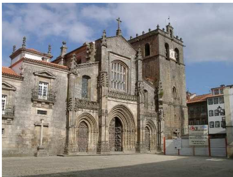
Fig. 45.1 – Fachada principal da Sé de Lamego [79]
