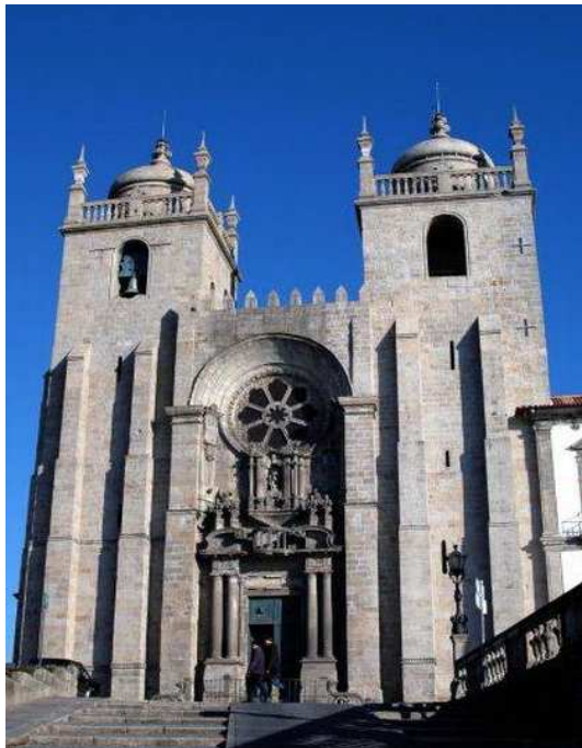
Fig. 46.2 – Fachada principal da Sé do Porto [81]
