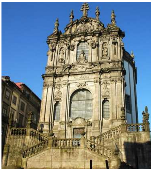
Fig. 8.1 – Fachada principal da igreja dos Clérigos (Porto) [18]
