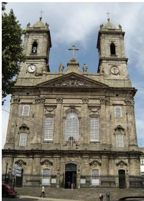
Fig. 11.1 – Fachada principal da igreja da Lapa (Porto) [23]
